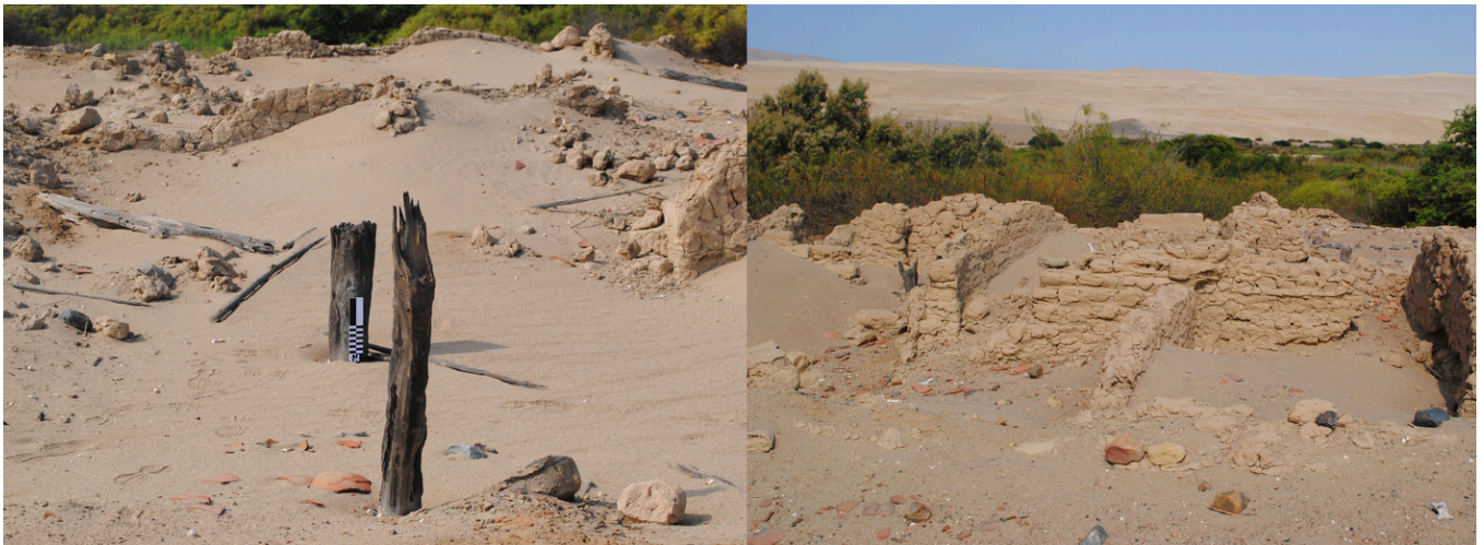
Fig. 8. Secciones de habitaciones conservadas. Se observa tipo de material de construcción, principalmente abobe y tapia.
