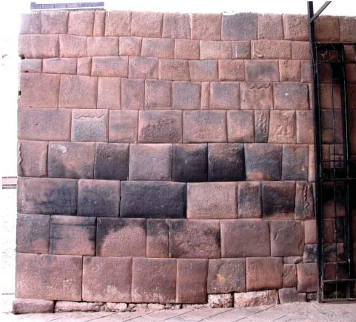
Figura 6. Sección de muro esquinero colonial del tipo «Cusco clásico» mostrando varias piezas líticas con motivos en alto relieve. Calle Siete Culebras, Plaza Nazarenas. Foto Gori Tumi 2006.
