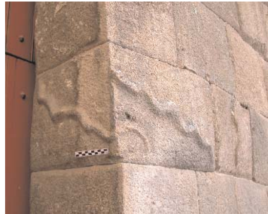
Figura 7. Muro colonial de vano en edificio tipo «Cusco clásico» mostrando figuras en alto relieve. Plaza Bicentenario. Foto Gori Tumi 2006.
