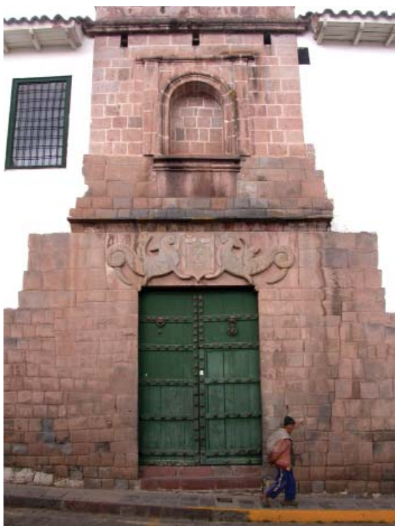
Figura 4. Fachada del Beaterio de las Nazarenas. Edificio probablemente construido a fines del siglo XVI. Foto Gori Tumi 2006.
