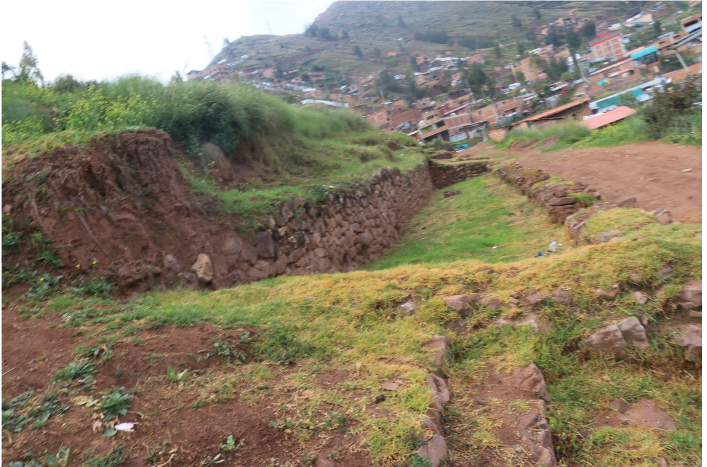
Figura 4: vista de una de las kallankas del sector bajo.
