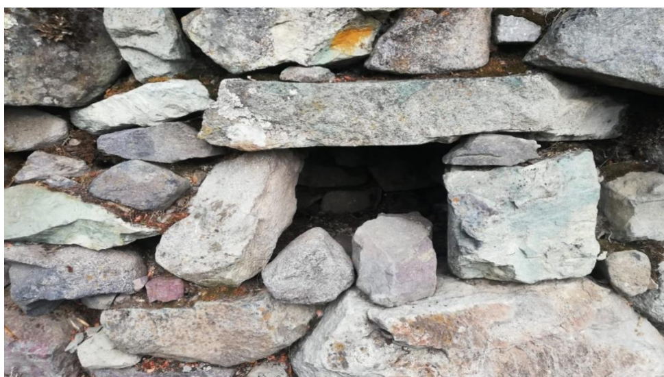
Figura 17: detalle de la técnica arquitectónica.
