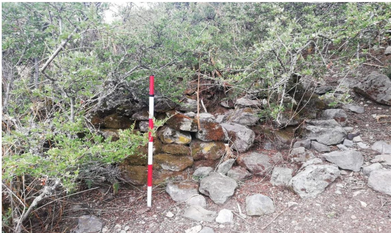
Figura 16: vista del recinto 5.
