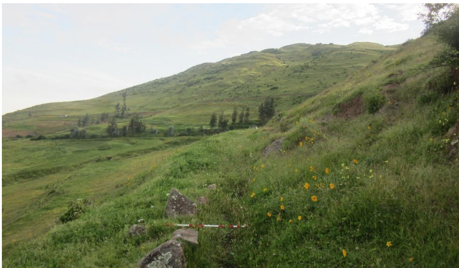
Figura 19: Vista panorámica del canal.
