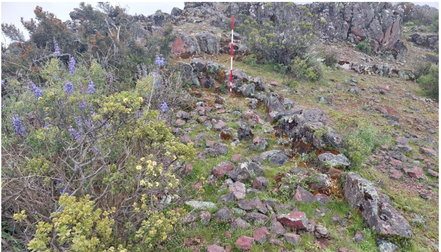
Figura 26: Recinto 2 en el cual se muestra el estado actual de este y el colapso a través de las piedras que se encuentran al interior.
