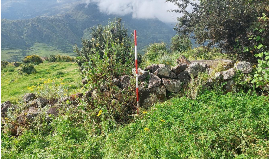
Figura 16: Vista de este a oeste del muro perimétrico.
