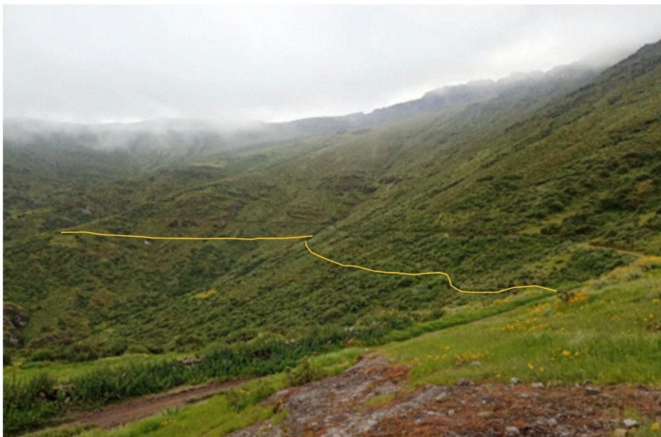
Figura 34: Vista panorámica de sur a norte de la afectación del camino por la construcción de la carretera, nótese la línea amarilla como proyección del camino.
