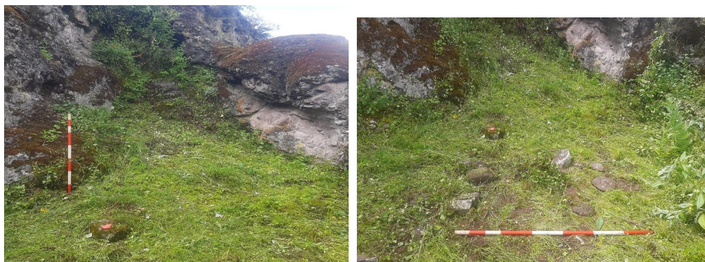
Figuras 64 y 65: Vista de dos edificaciones muy deterioradas.
