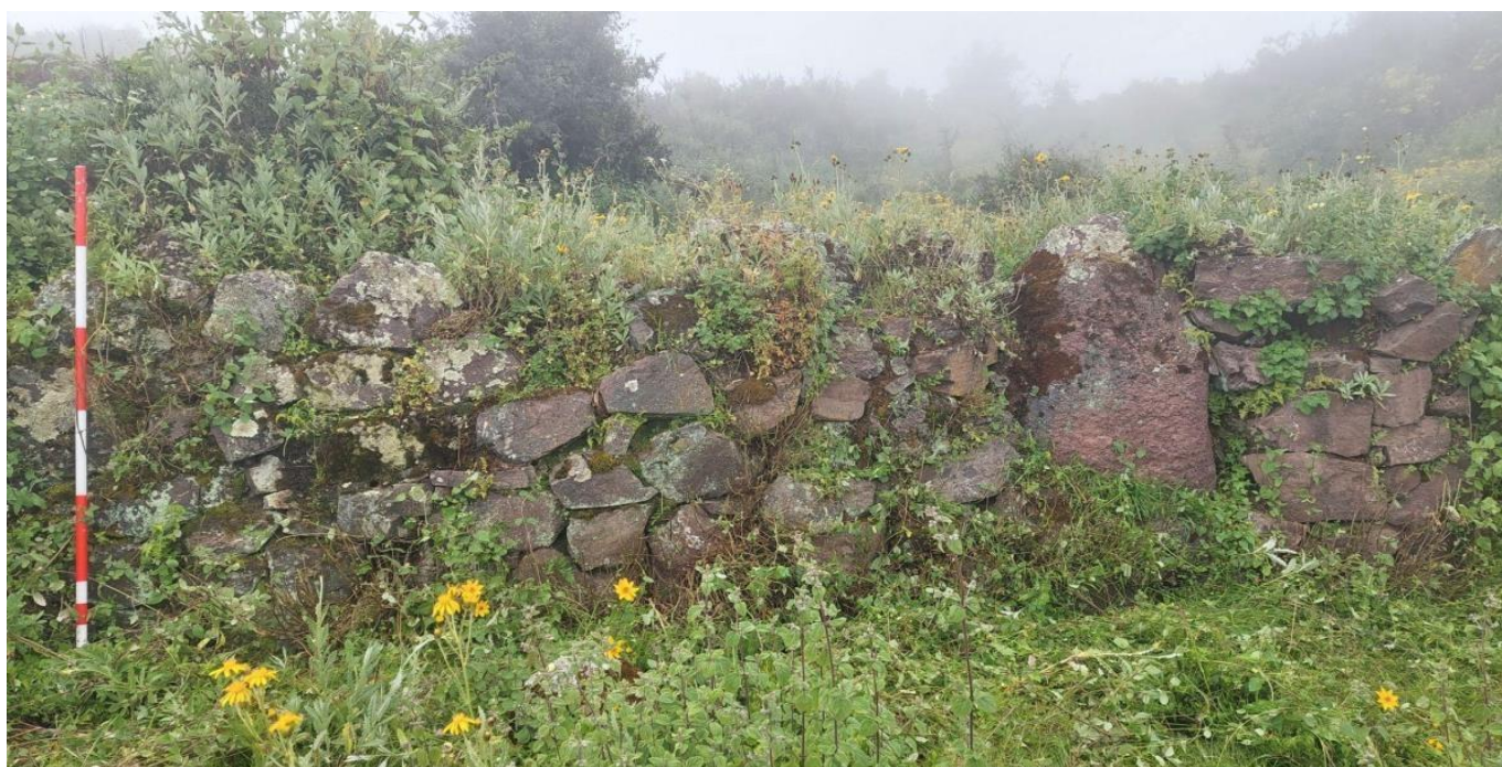
Figura 45: Muro perimetral que rodea la ladera en la cual se denota el material y técnica constructiva.
