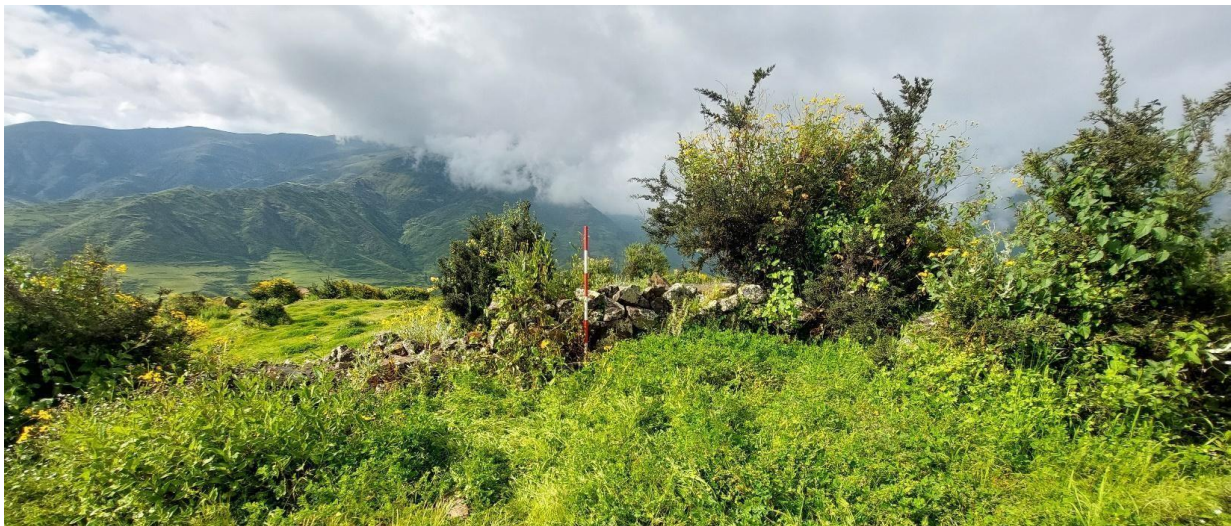
Figura 17: Vista panorámica de este a oeste del muro perimétrico.
