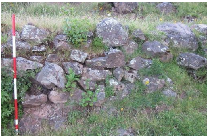
Figuras 23 y 24: Muro de contención emplazado en la parte más empinada, detalles del muro, uso de la piedra y mortero.
