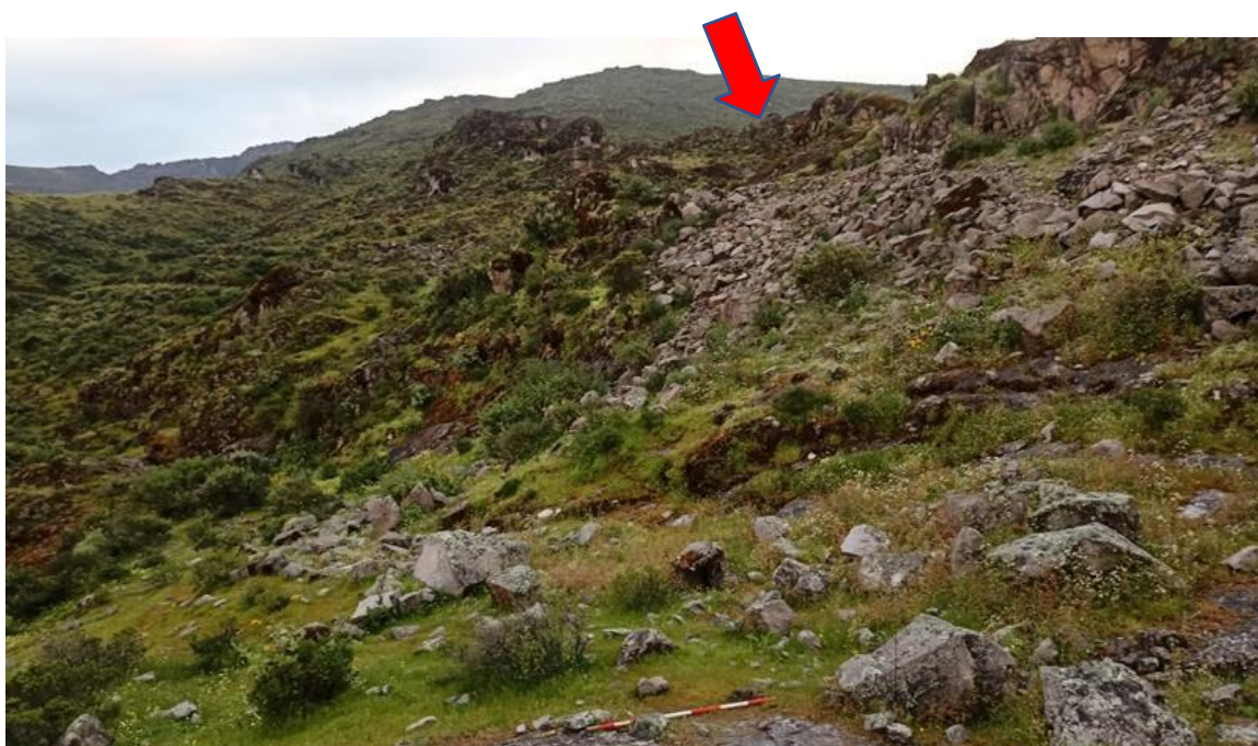
Figura 35: Vista de sur a norte de la afectación del camino por la construcción de la carretera. La flecha roja indica el paso de la vía moderna cortando el camino.
