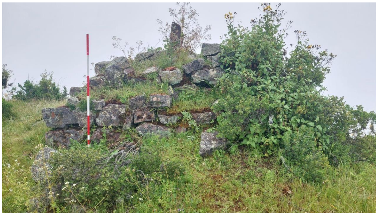
Figura 43: Vista de la estructura cuadrangular en la cual denota el estado de conservación.
