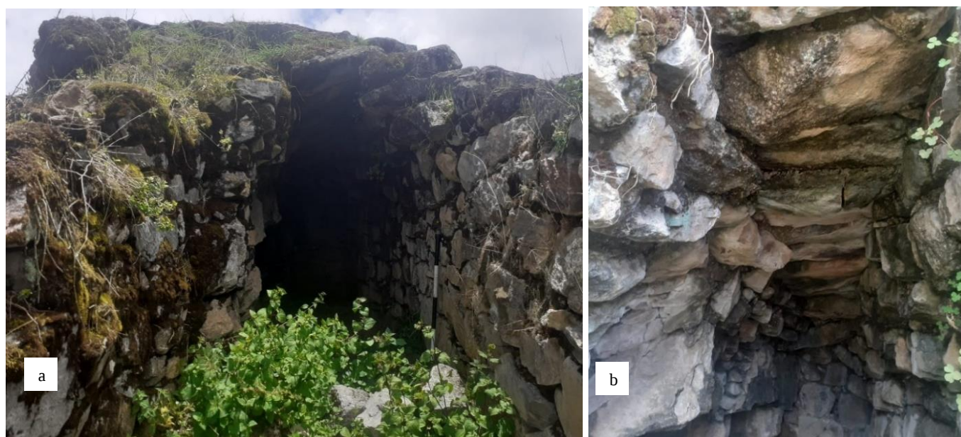
Figura 12. (a) Vista de la entrada de la Comandancia que pudo haber funcionado como almacén. (b) Detalle de la cubierta conformado por lajas.
