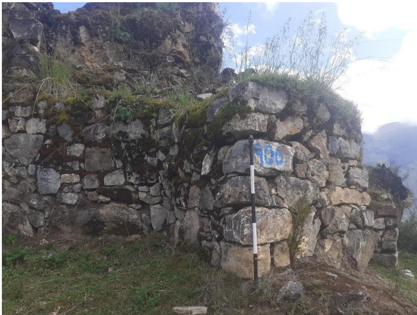
Figura 10. Vista de uno de los contrafuertes construidos en la parte externa del sitio.
