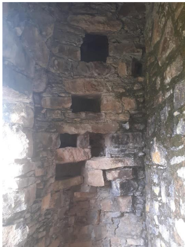
Figura 23. Vista de los nichos ubicado en lado izquierdo del recinto 05.
