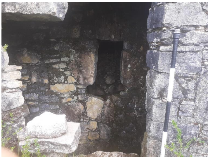
Figura 22. Muro divisorio con vano de acceso sobre el suelo del recinto 05.
