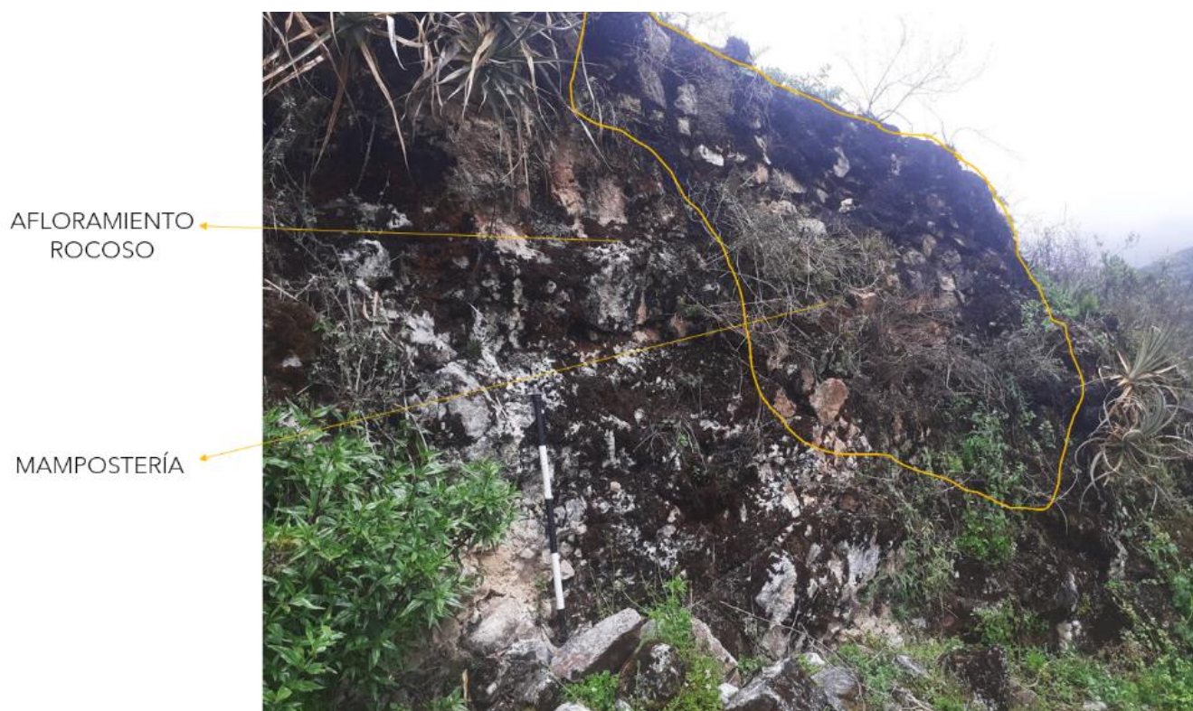
Figura 14. Detalle de la mampostería visible en el afloramiento rocoso marcado con línea anaranjada.
