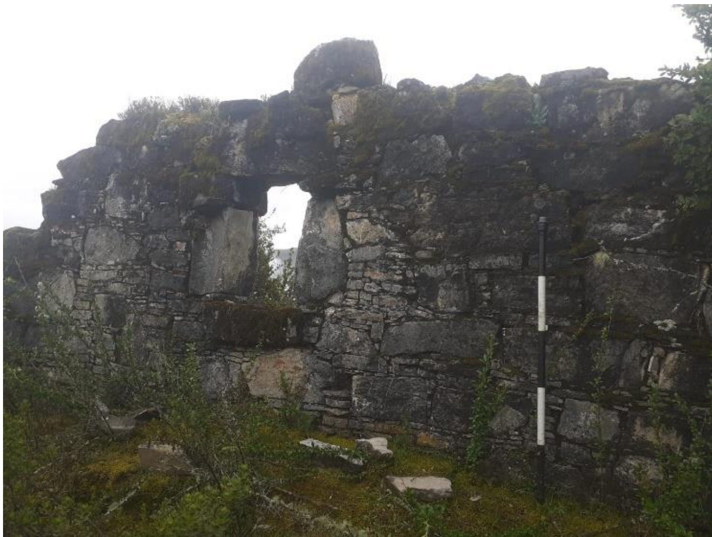
Figura 18. Vista del recinto 1 que se encuentra parcialmente alterado.
