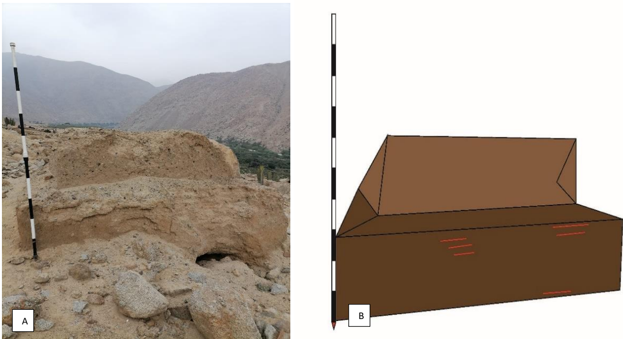
Figura 09: (A) fotografía señalando el proceso de construcción Rampa (B) representación gráfica de la rampa N° 7.
