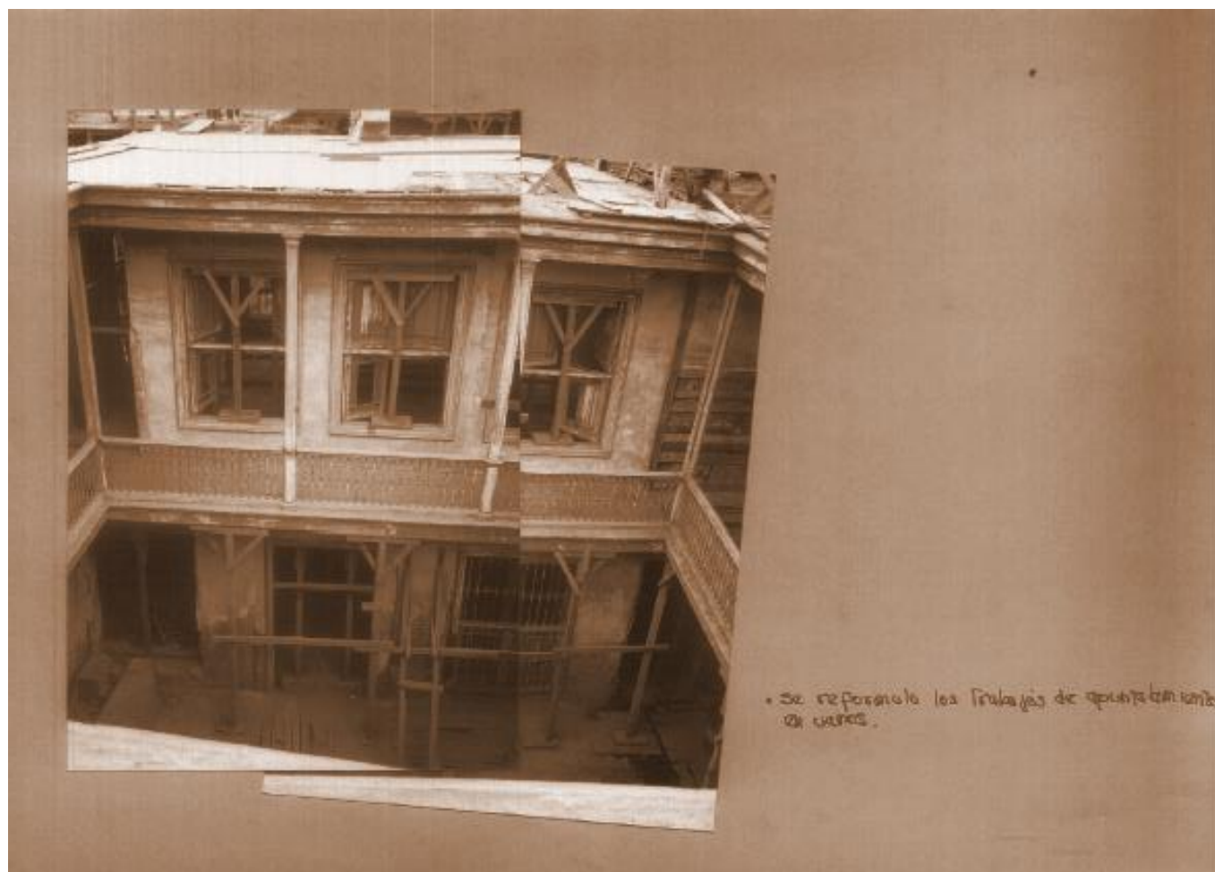
Figura 12. Vista de reformulación de apuntalamiento de vanos. Fuente Arriola 1998.
