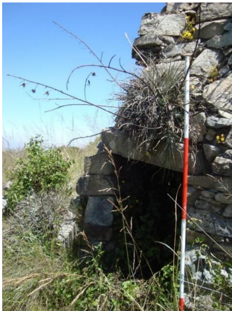
Figura 18: Estructura que presenta una cámara subterránea.
