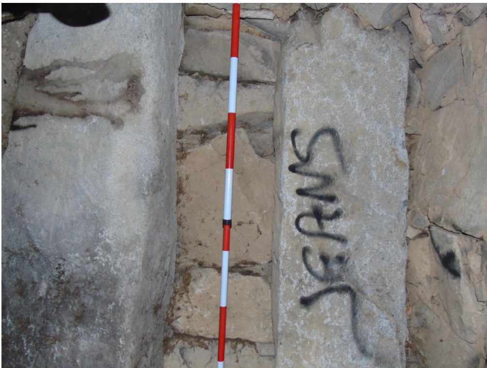
Figura 5: Construcción del techo en la cámara 1: los bloques como vigas y lajas de piedra colocadas sobre ellos.
