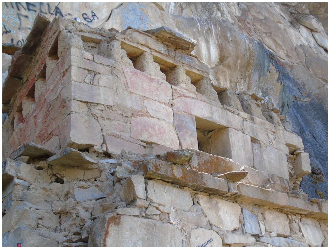
Figura 9: vista del muro oeste del segundo piso.
