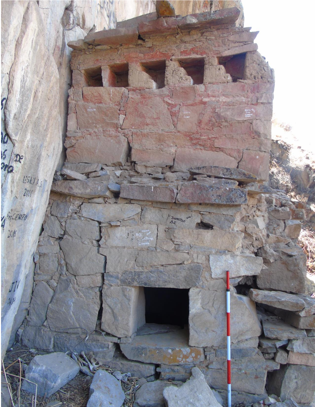
Figura 2: muro norte de la estructura funeraria.
