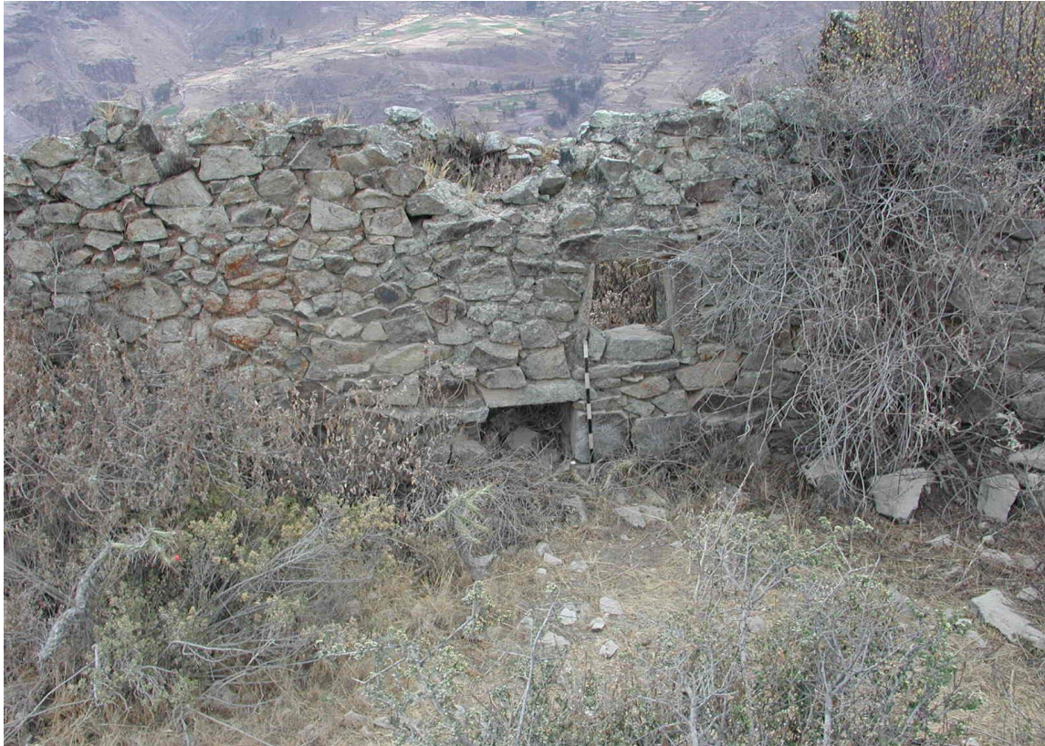
Figura 12: Vano que accede al primer y segundo nivel de compartimiento interno de recinto en Tambo de Llacsatambo.
