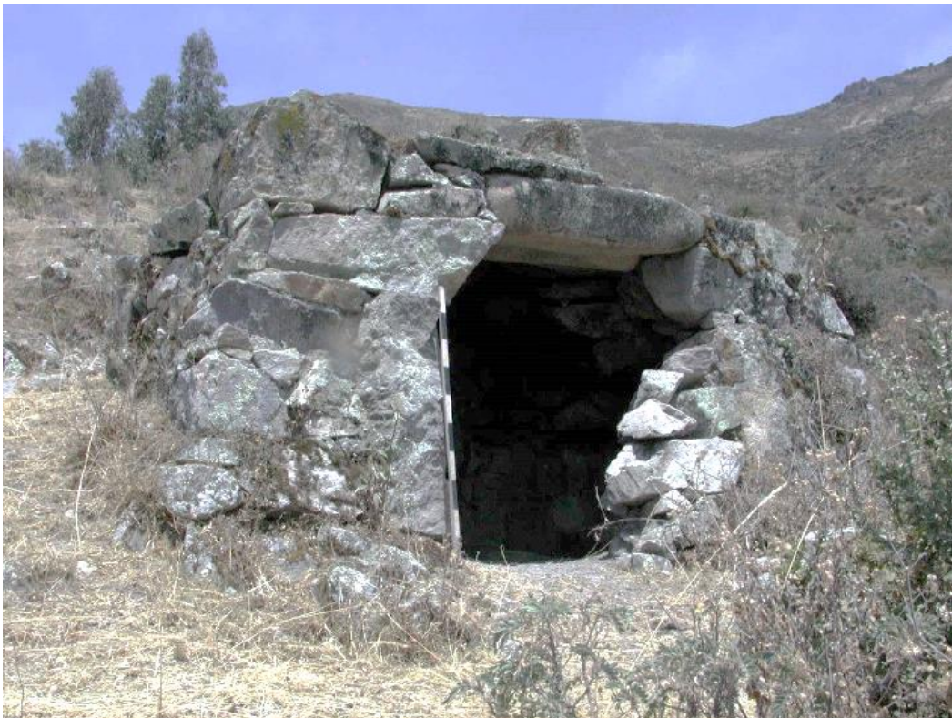
Figura 7: "Chaucalla de Pasayque": detalle de la fachada principal.
