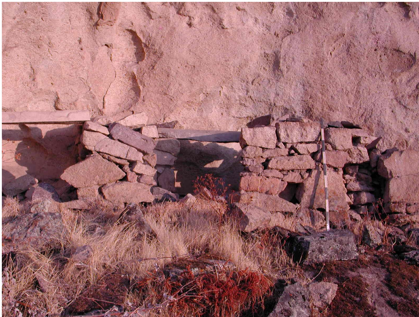
Figura 11: Vista de las cámaras internas de chaucalla en Cerro Calavera.
