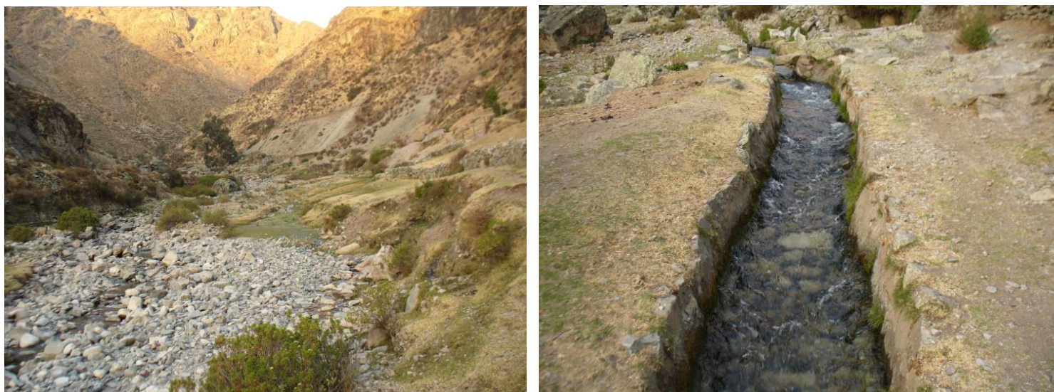
Figura 33 (izquierda): Toma de canal de Chauquilla - carretera moderna. Figura 34 (derecha): canal de Chauquilla - empedrado reforzado con cemento.
