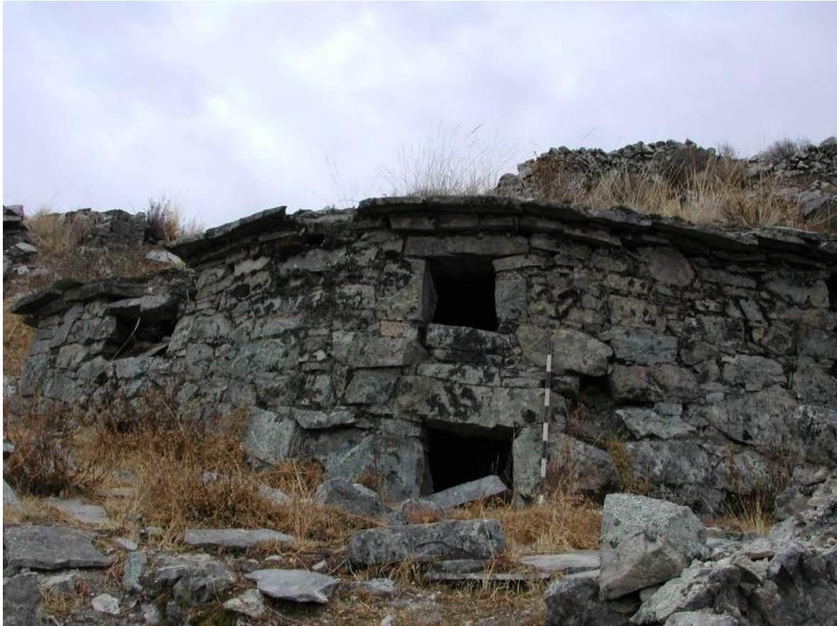
Figura 18: "Chulpa" de dos pisos con muros curvos visto de oeste - este.
