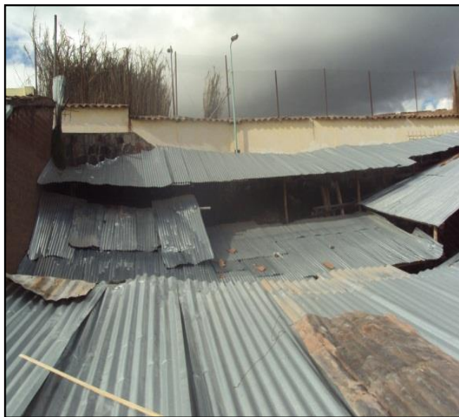
Figuras 14 y 15: Cambio de cubierta por colapsamiento total con teja colonial sobre torta de barro.
