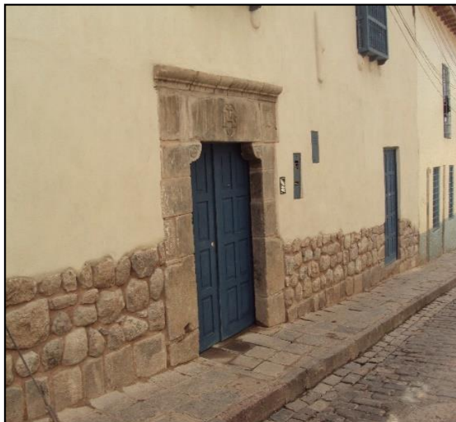
Figuras 16 y 17: Embarres, consolidación de sobrecimiento, así como pintado de la facha interior y exterior.
