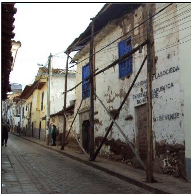
Figura 3 (izquierda): Fachada del inmueble apuntalamiento con rollizos de eucalipto. Figura 4 (derecha): Fachada del inmueble con cubierta de calamina para la protección de lluvias.
