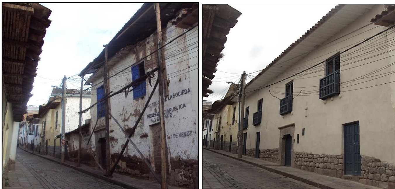
Figuras 21 y 22: Fachada de la casona: estado actual antes y después de la intervención.
