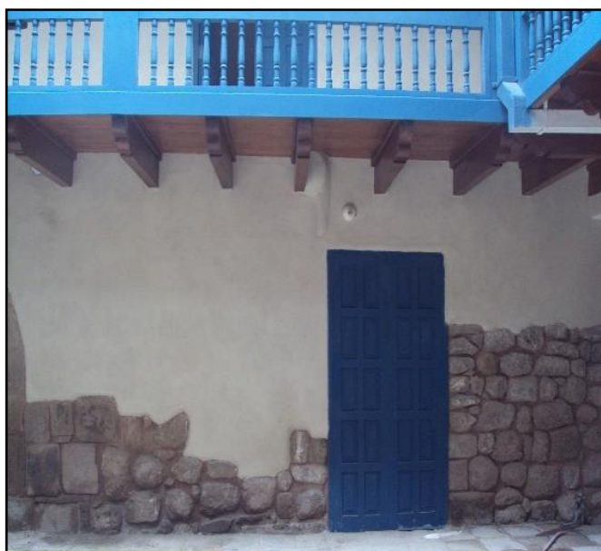
Figuras 16 y 17: Embarres, consolidación de sobrecimiento, así como pintado de la facha interior y exterior.
