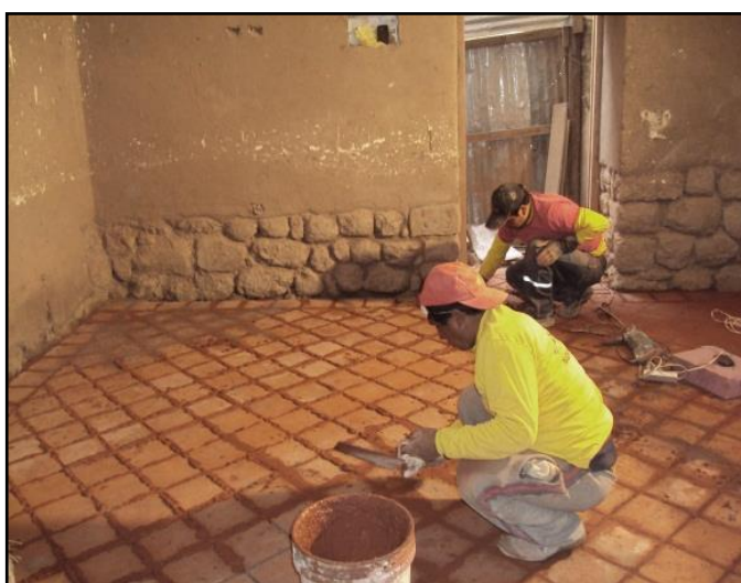
Figura 18 (izquierda): Colocado de ladrillo pastelero. Figura 19 (derecha): Recomposición de piso con lajas de piedra patio principal del inmueble.
