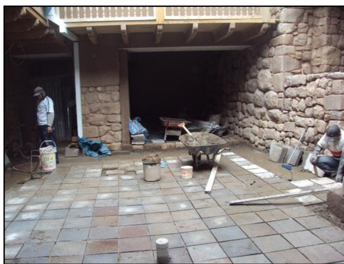
Figura 18 (izquierda): Colocado de ladrillo pastelero. Figura 19 (derecha): Recomposición de piso con lajas de piedra patio principal del inmueble.
