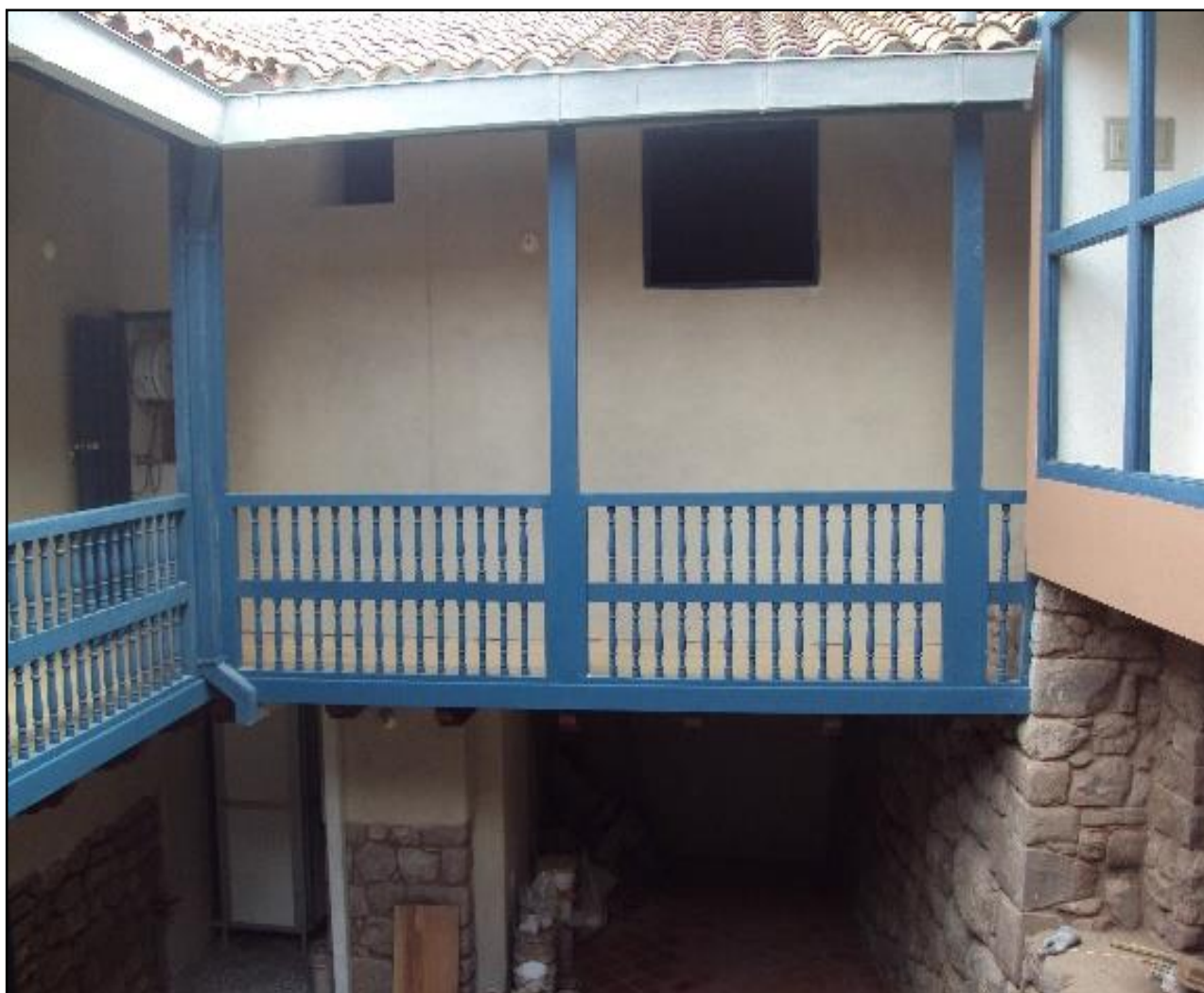
Figura 9: Balastrada de madera restaurada del corredor y pintados según proyecto aprobado.
