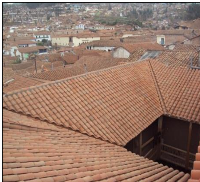
Figuras 14 y 15: Cambio de cubierta por colapsamiento total con teja colonial sobre torta de barro.
