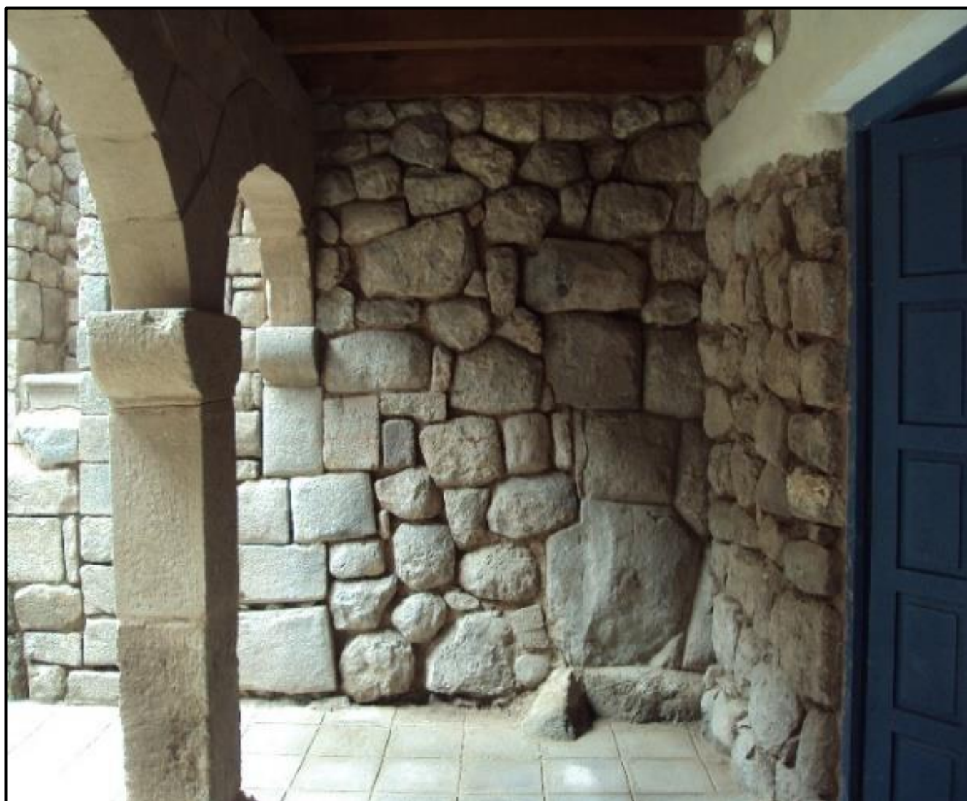
Figura 7: Consolidación de muro de piedra y arco de medio punto al interior de la casona con material propio.
