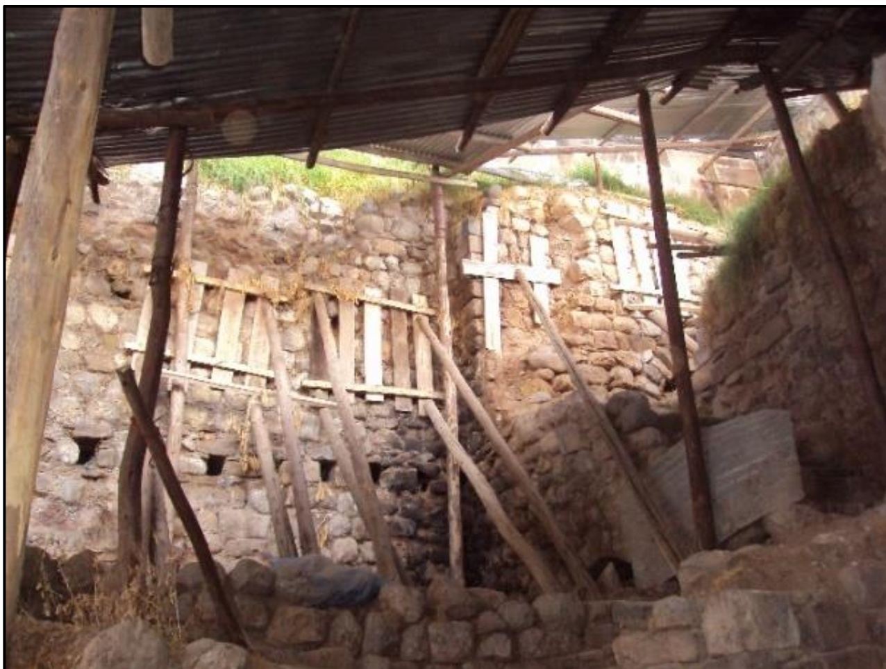
Figura 5: Vista de apuntalamiento de muros.
