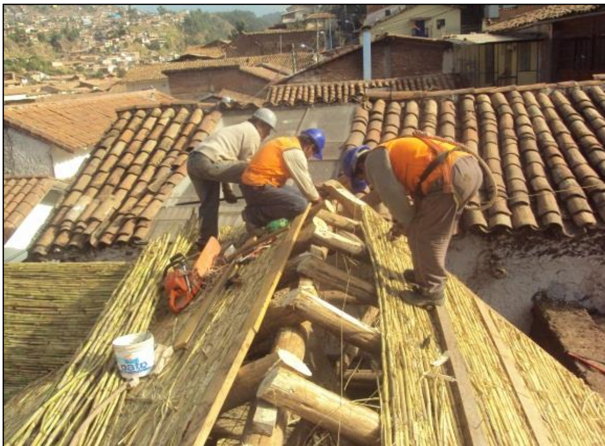
Figuras 12 (página anterior) y 13: Uso de materiales de la zona como: carrizo, palos de eucalipto y teja colonial.
