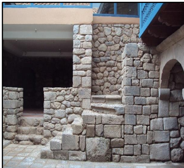
Figuras 10 y 11: Muros de piedra restaurados con material propio, estado actual y acabado ubicado en patio central del inmueble.
