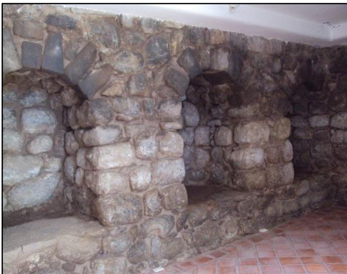
Figura 8: Arcos coloniales de descarga restaurada y piso de ladrillo pastelero.
