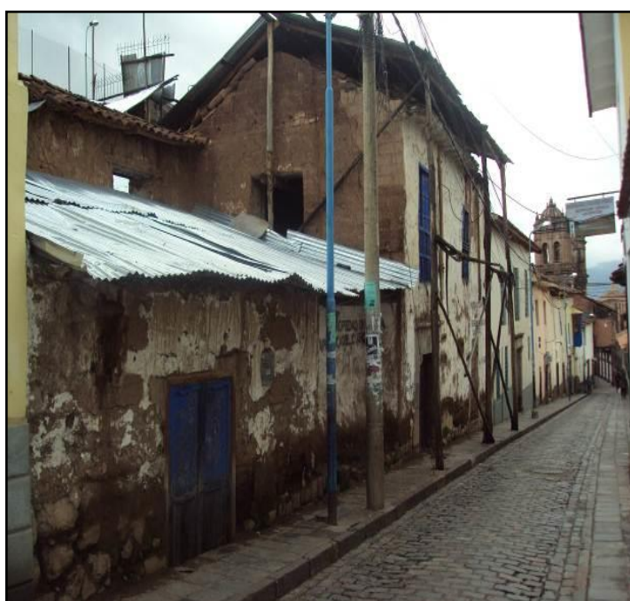
Figura 3 (izquierda): Fachada del inmueble apuntalamiento con rollizos de eucalipto. Figura 4 (derecha): Fachada del inmueble con cubierta de calamina para la protección de lluvias.
