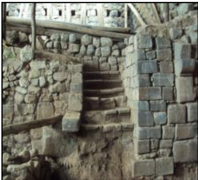
Figuras 10 y 11: Muros de piedra restaurados con material propio, estado actual y acabado ubicado en patio central del inmueble.
