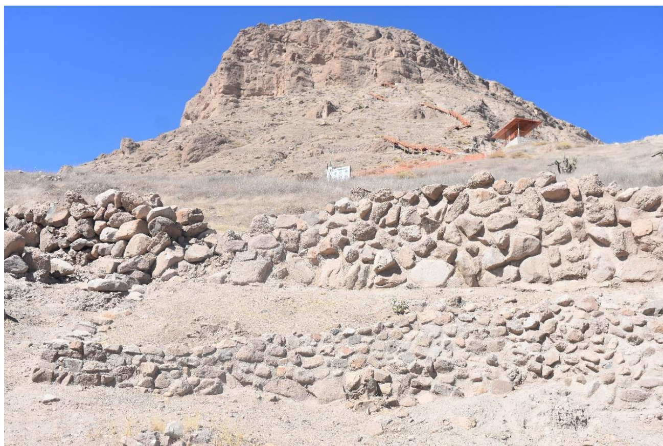
Figura 2: Vista en detalle de la parte central de la primera Muralla, sector F, Cerro Baúl.
