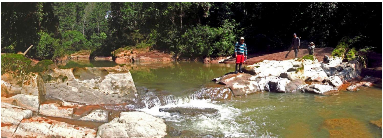
Figura 14: Bloque tabular de roca arenisca atravesando el cauce del río, con fractura en la parte central por acción del agua. Notar bloque desprendido yacente al pie de la fractura. Foto Gori-Tumi 2015.
