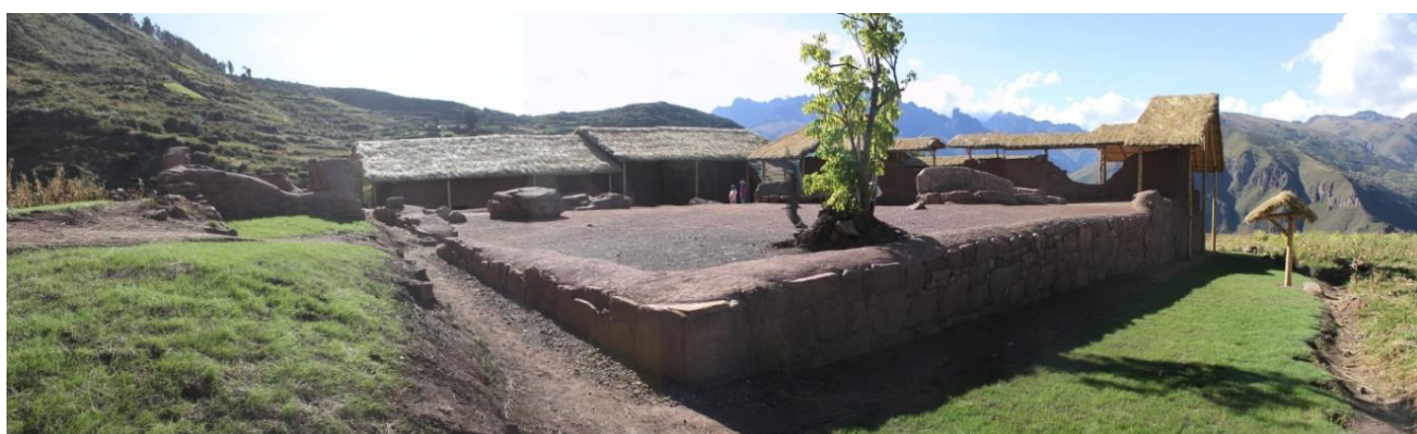
Figura 21: Muro de contención que delimita Rozaskancha y sostiene el edificio 02 y 03.
