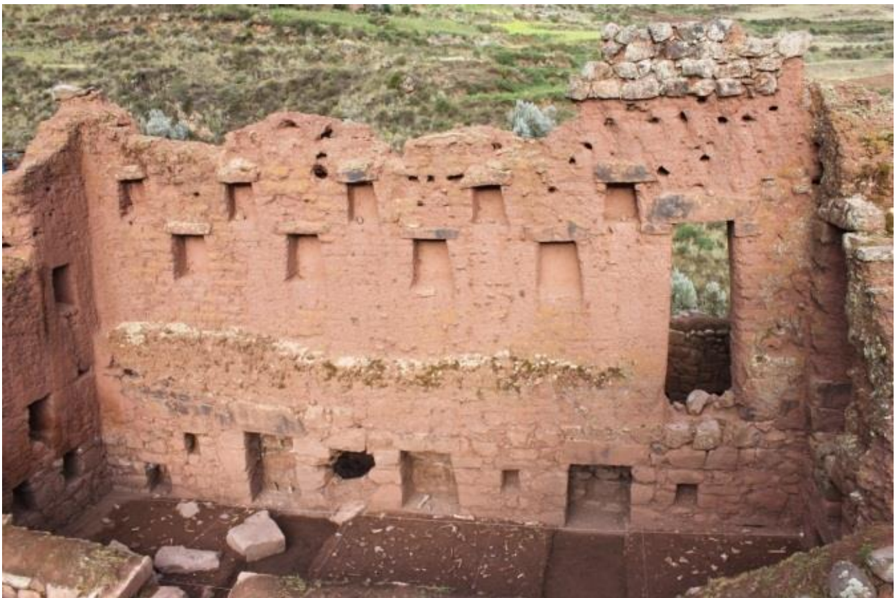
Figura 16: Ambiente "A". Vano de acceso al ambiente "B".
