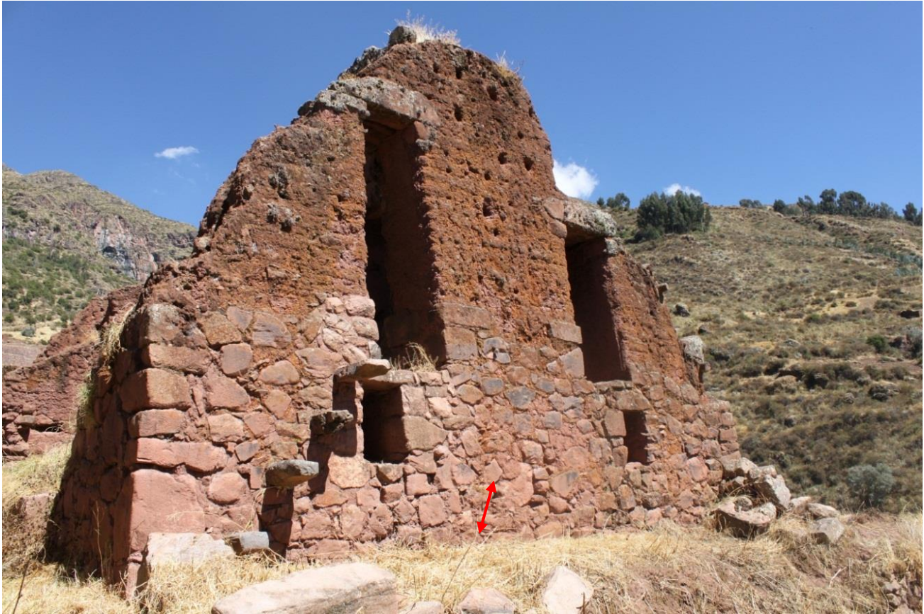
Figura 15: Recinto 03 A y B muro exterior Norte.
