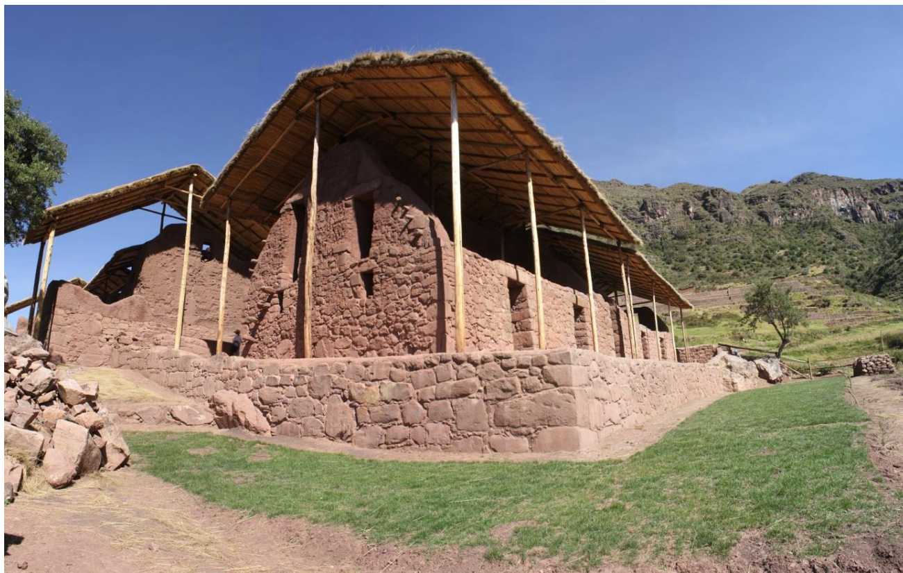
Figura 22: Muro de contención que delimita Rozaskancha.
