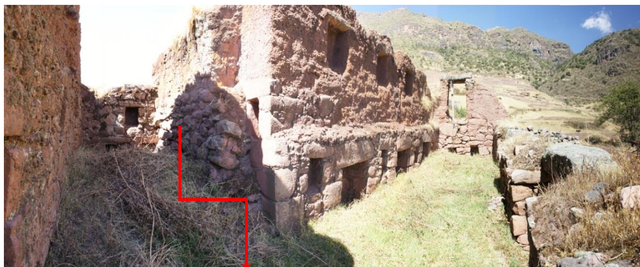
Figura 3: Muro edificado posteriormente.
