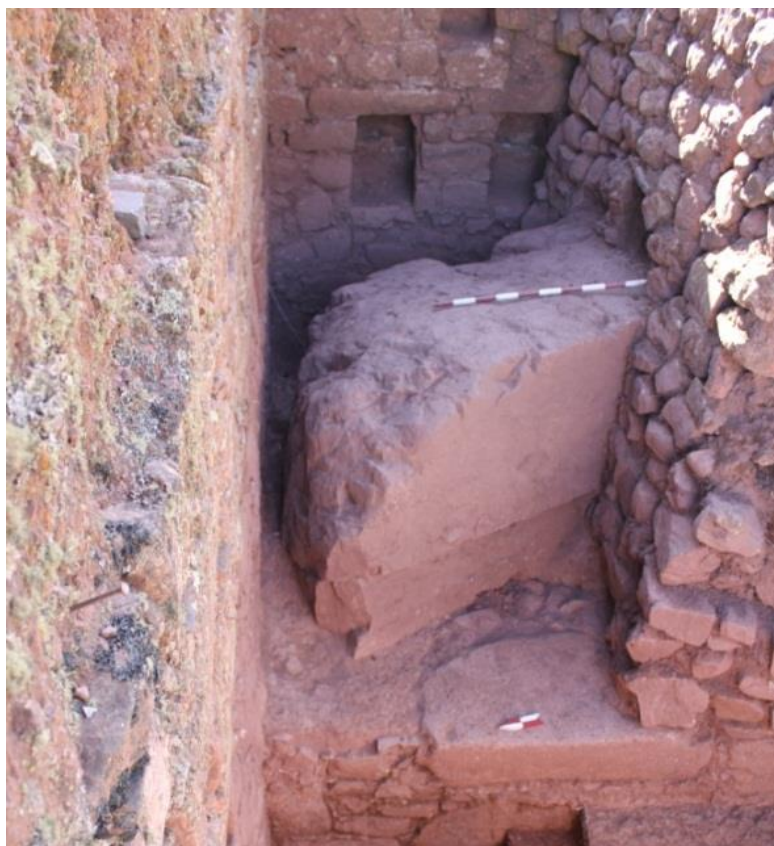
Figura 34: Recinto 02. Muro construido posteriormente sobre la roca labrada.
