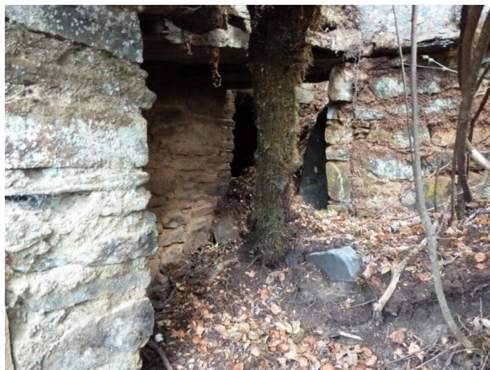
Figura 73 (izquierda): Vista del interior del recinto del sector D, en donde se aprecian diversas divisiones.
