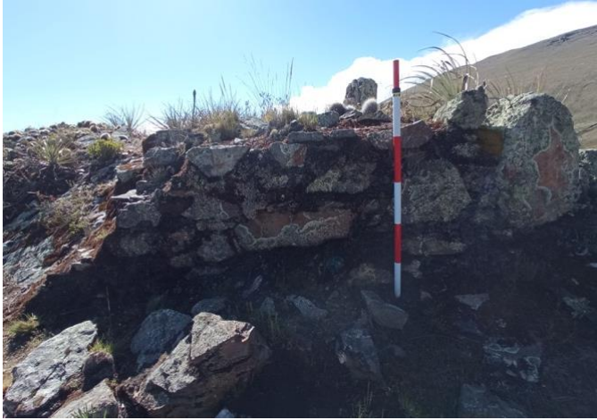
Figura 117 (izquierda): muro sur de la última plataforma de la estructura se aprecia la técnica constructiva de piedras canteadas y argamasa de barro. Figura 118 (derecha): muro superior noreste se aprecia la técnica Huanca-Pachilla.
