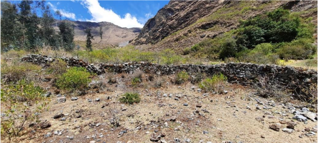
Figura 91: Vista del muro del recinto mejor conservado.
