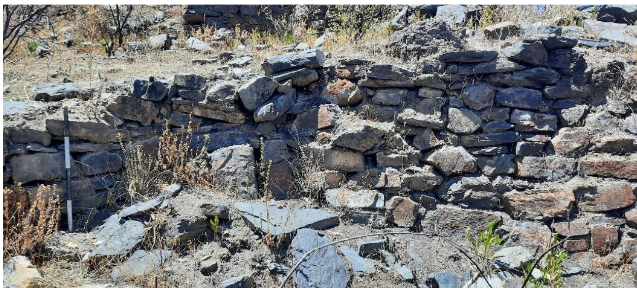
Figura 86: Vista en detalle de la base del muro de contención de una terraza.
