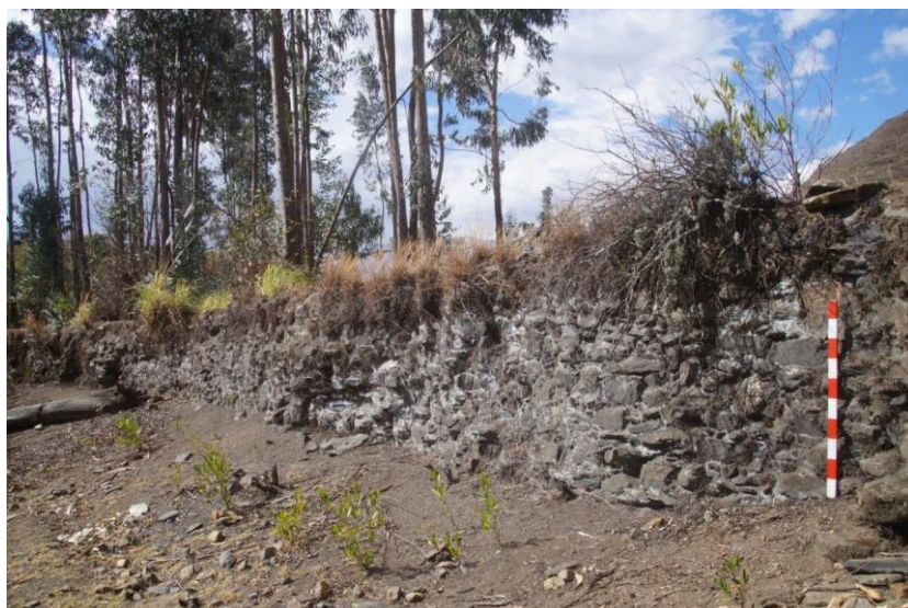
Figura 52: Detalle del muro de contención de canal.
