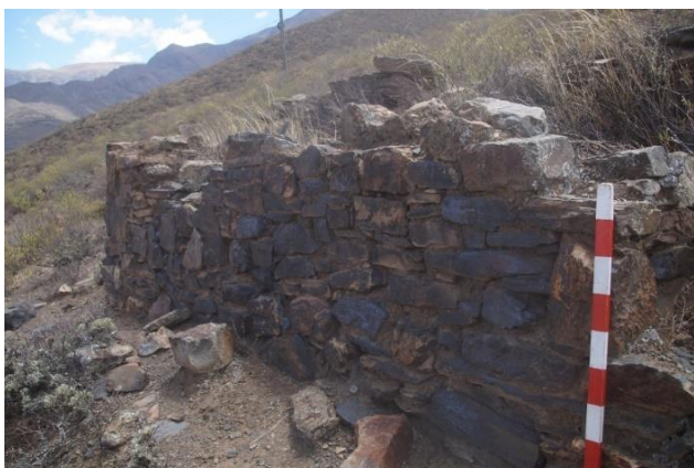
Figura 37 (izquierda): Detalle de la composición de la parte lateral del muro de contención del sitio arqueológico Condorcenja. Figura 38 (derecha): Detalle del muro de contención de doble hilera contención del sitio arqueológico Condorcenja.
