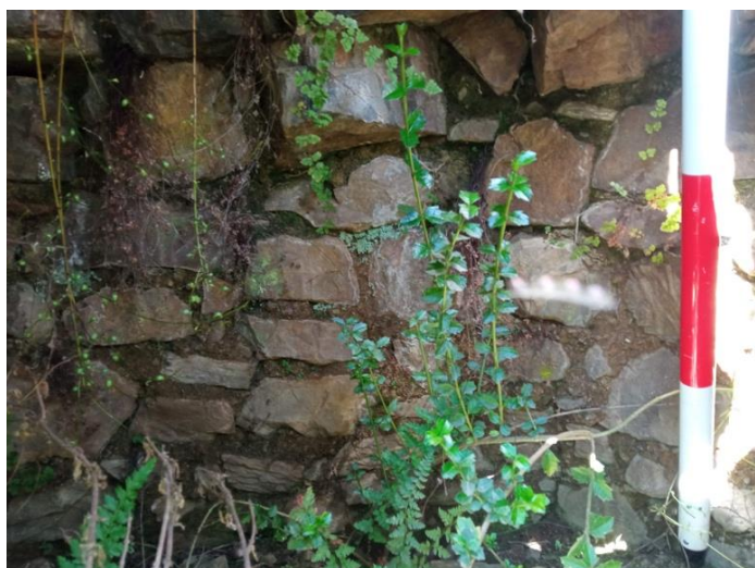
Figura 121 (izquierda): paramento interior de la Chulpa 1, se observa la técnica arquitectónica de piedras canteadas, de rústico acabado y mortero de barro. Figura 122 (derecha): vista panorámica del muro A, el mejor elaborado de todo el sitio.
