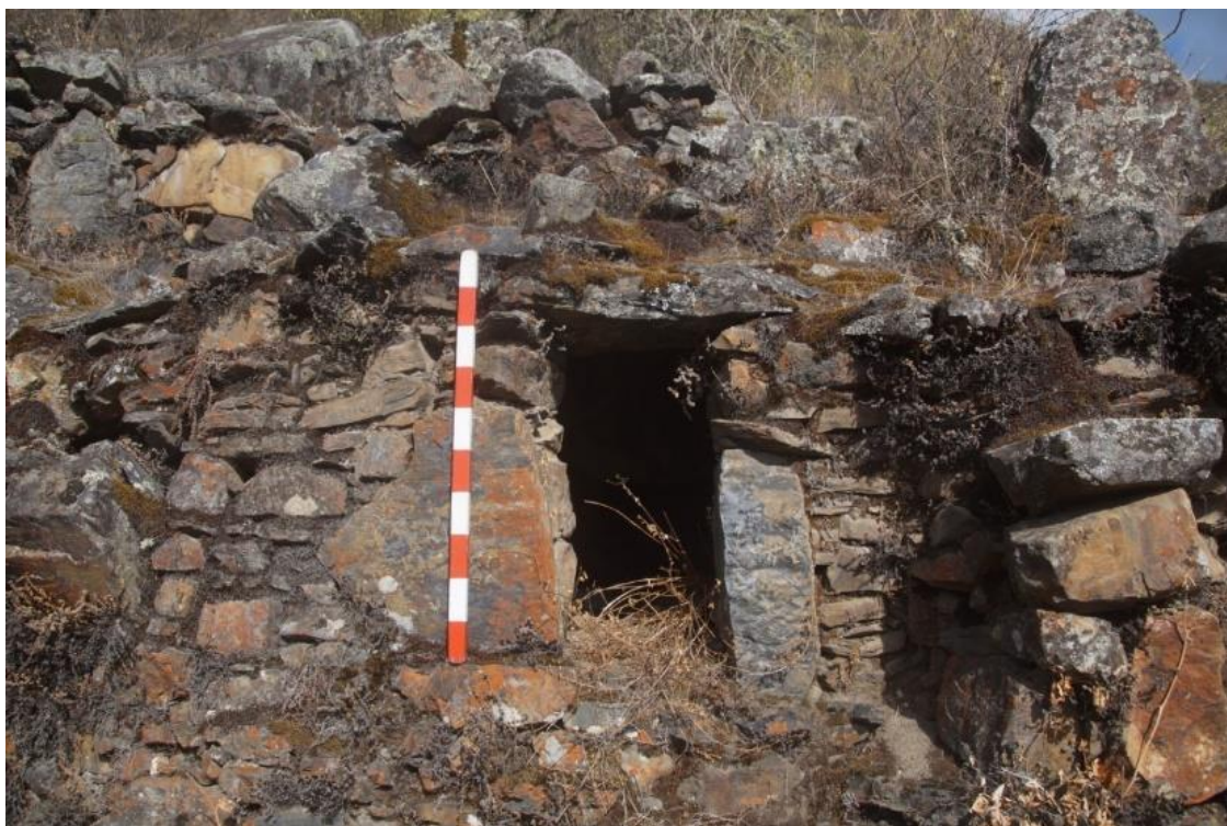
Figura 53: Detalle del vano de acceso de la estructura rectangular adosada al talud del cerro del sitio arqueológico Ayarquta.
