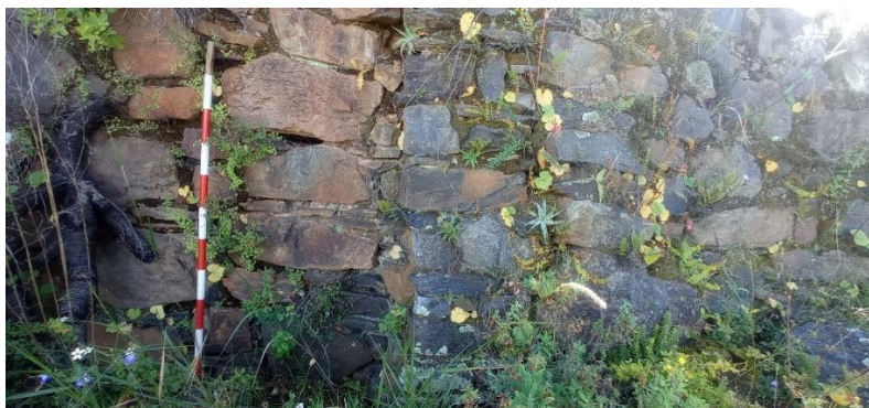
Figura 30: vista de frente de la estructura 8, sector C.
