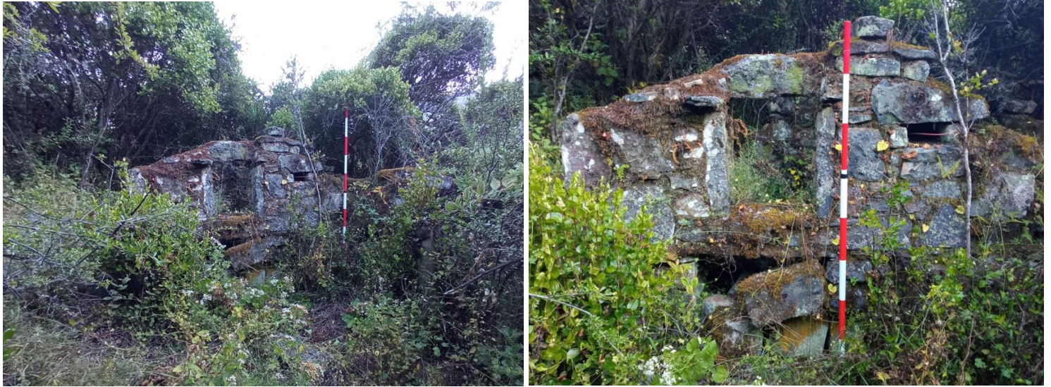
Figura 94 (izquierda): Estructura 1, muro con vano que divide la estructura rectangular, los muros que dan al exterior de la estructura no se aprecian por la densa vegetación que los cubre. Figura 95 (derecha): detalle del vano del muro que divide la estructura 1, en la fotografía se muestra el paramento este del muro.
