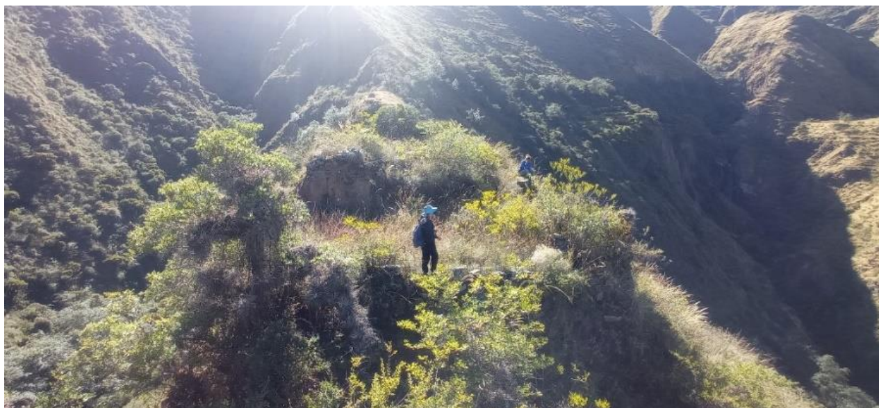
Figura 31: Vista del sector C, donde se observa algunas estructuras en regular estado de conservación.
