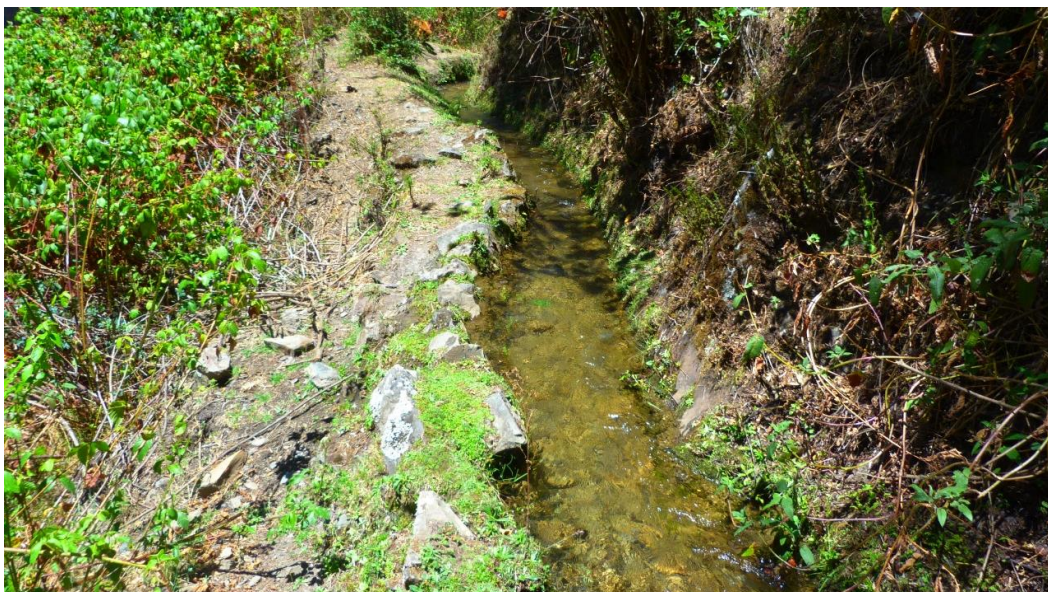
Figura 125: Detalle del canal denominado Toma.
