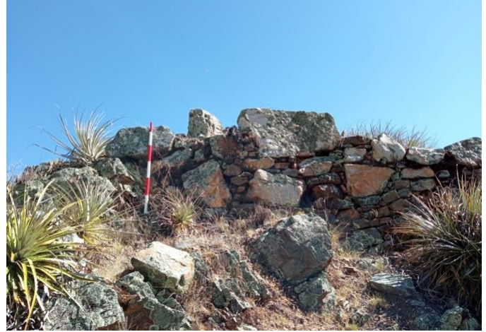
Figura 117 (izquierda): muro sur de la última plataforma de la estructura se aprecia la técnica constructiva de piedras canteadas y argamasa de barro. Figura 118 (derecha): muro superior noreste se aprecia la técnica Huanca-Pachilla.
