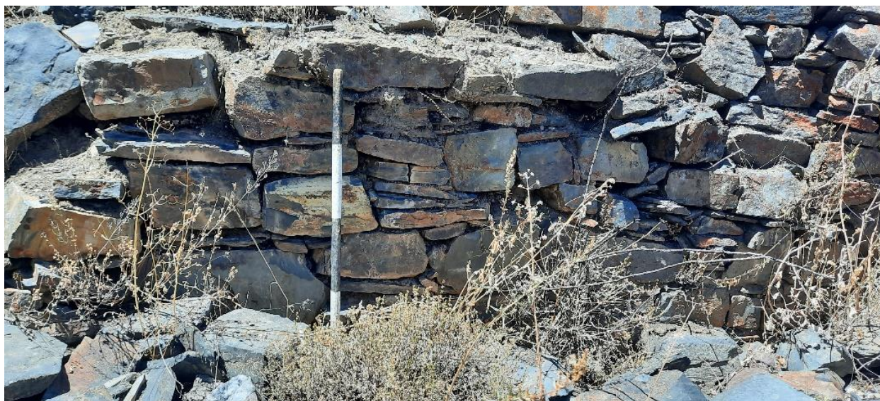
Figura 85: Vista del muro de contención de una terraza.
