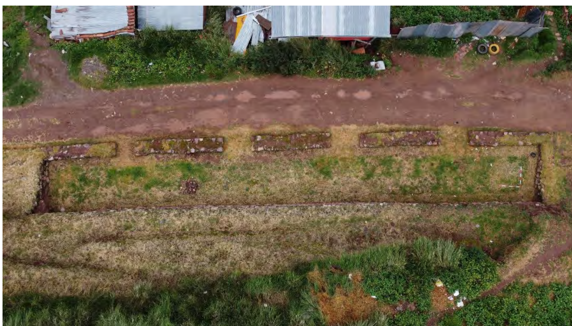
Figura 5: vista aérea de una kallankas del sector bajo.
