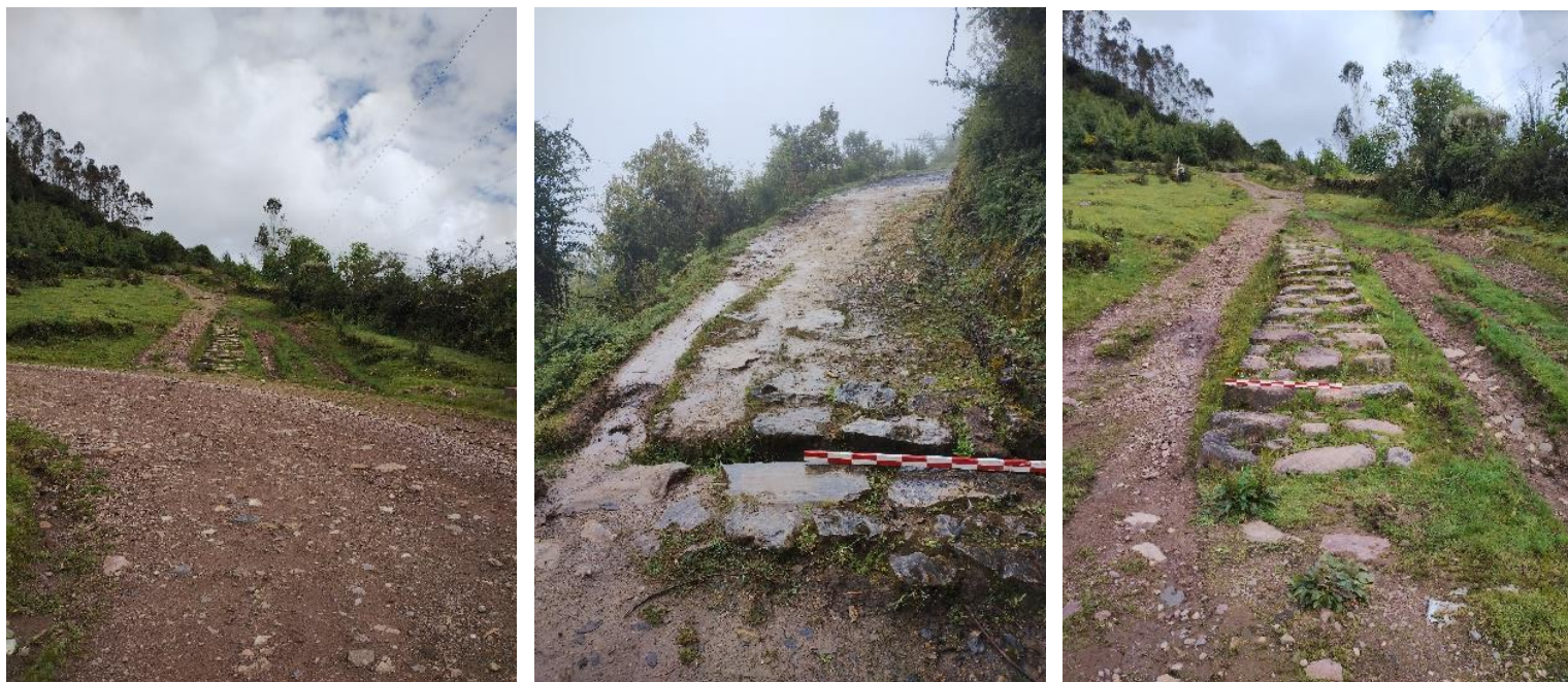
Figuras 9, 10 y 11: Sección Vilcabamba La Nueva – Collpaqhasa, cortada por el trazo de la trocha carrozable, misma sección con plataforma empedrada y dren superficial, luego escalinatas.
