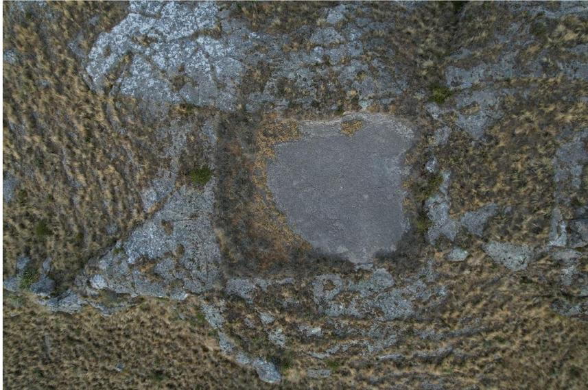
**Figura 140: Reservorio hecho en roca sedimentaria. Foto de planta.**
