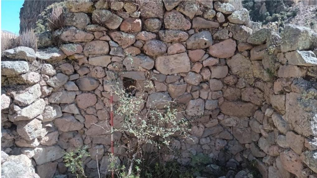
**Figura 20 Paramento de estructura de planta rectangular con nicho o hornacina.**
