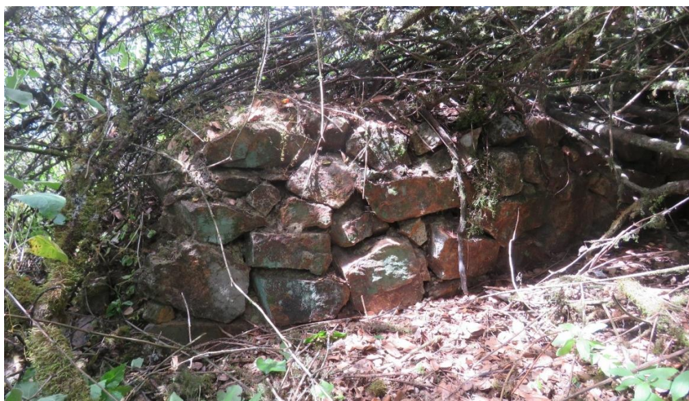
Figura 96: Muro lateral del camino.
