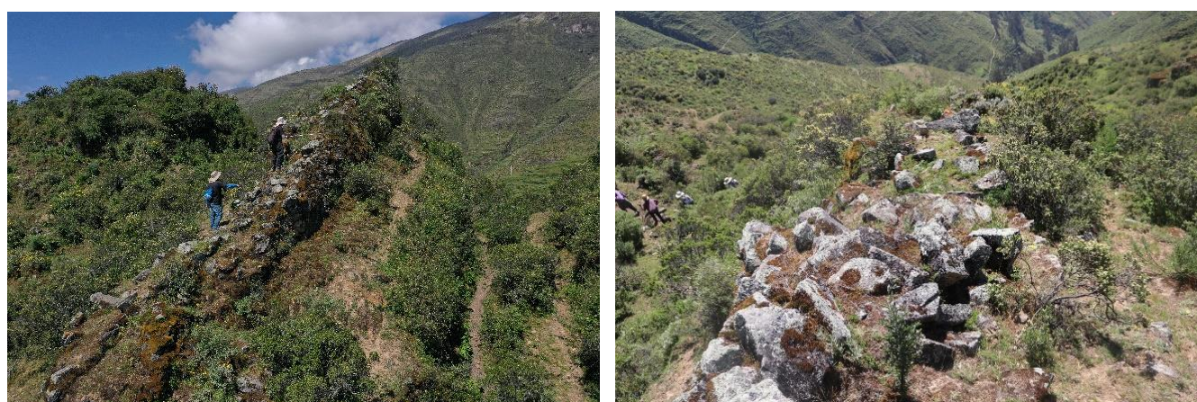
Figura 195 (izquierda): muralla 02, el cual presenta un muro de apoyo paralelo en el lado Noroeste. Figura 196 (derecha): muralla 02.
