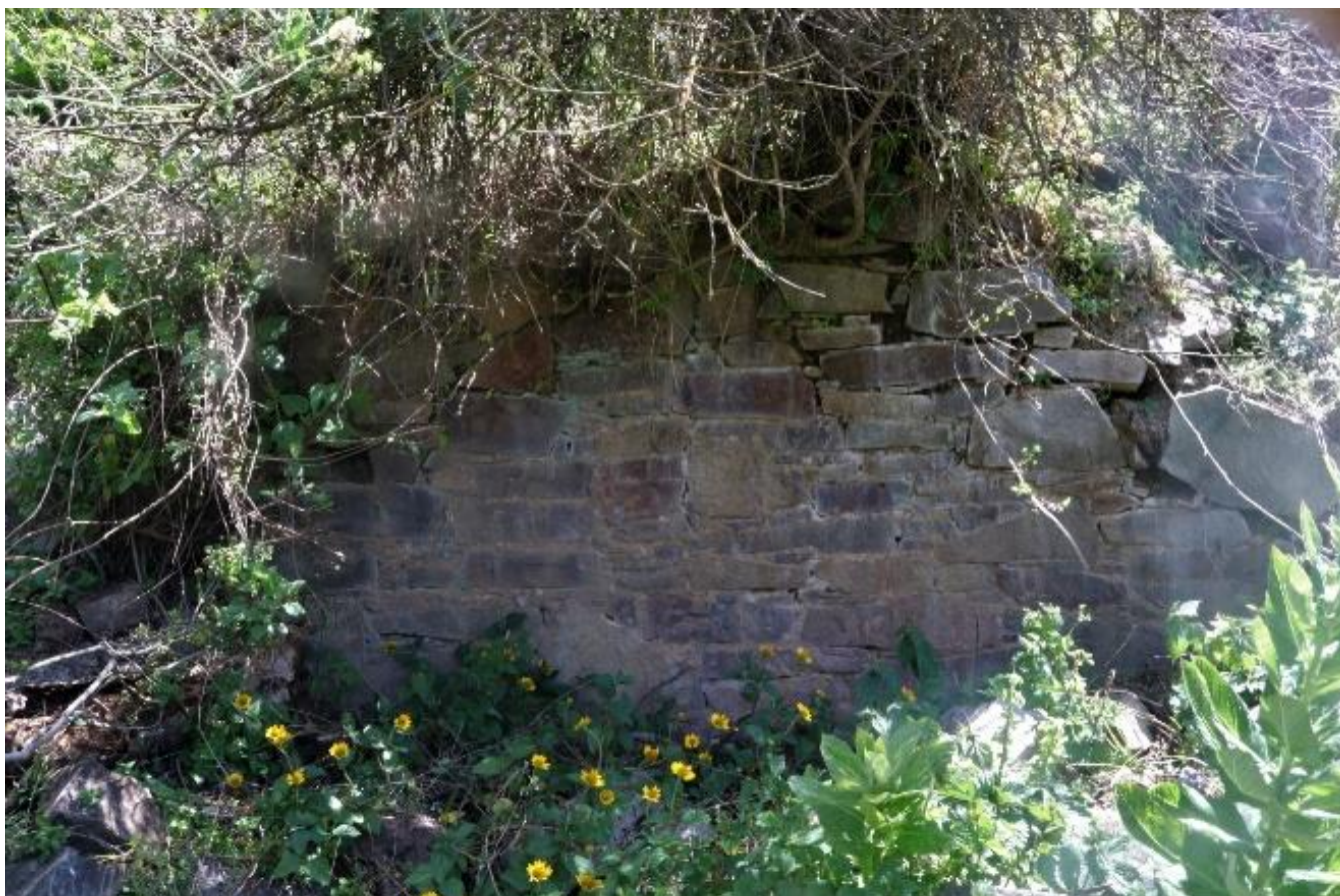
Figura 197: secciones de muros de estructuras que se encontraban en el sitio.
