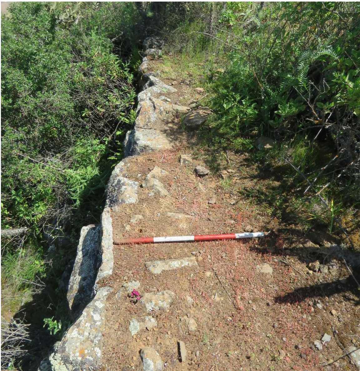
Figura 78: Muro de contención.
