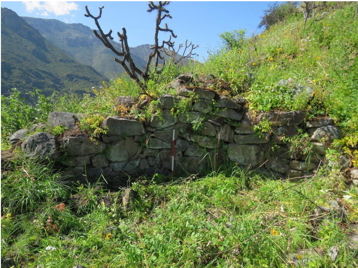
Figura 67: Paramento interno de un recinto.
