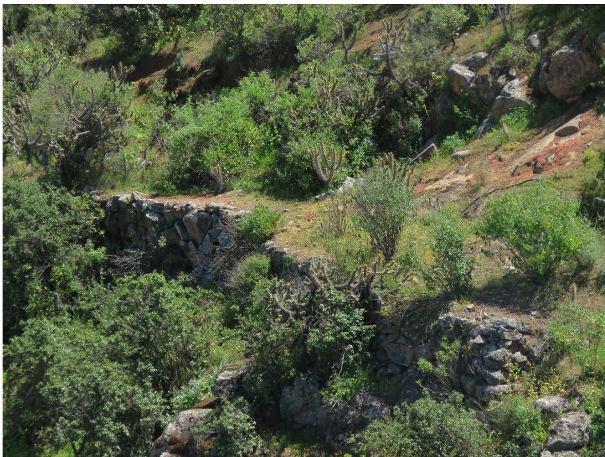
Figura 79: Muro de contención de camino.
