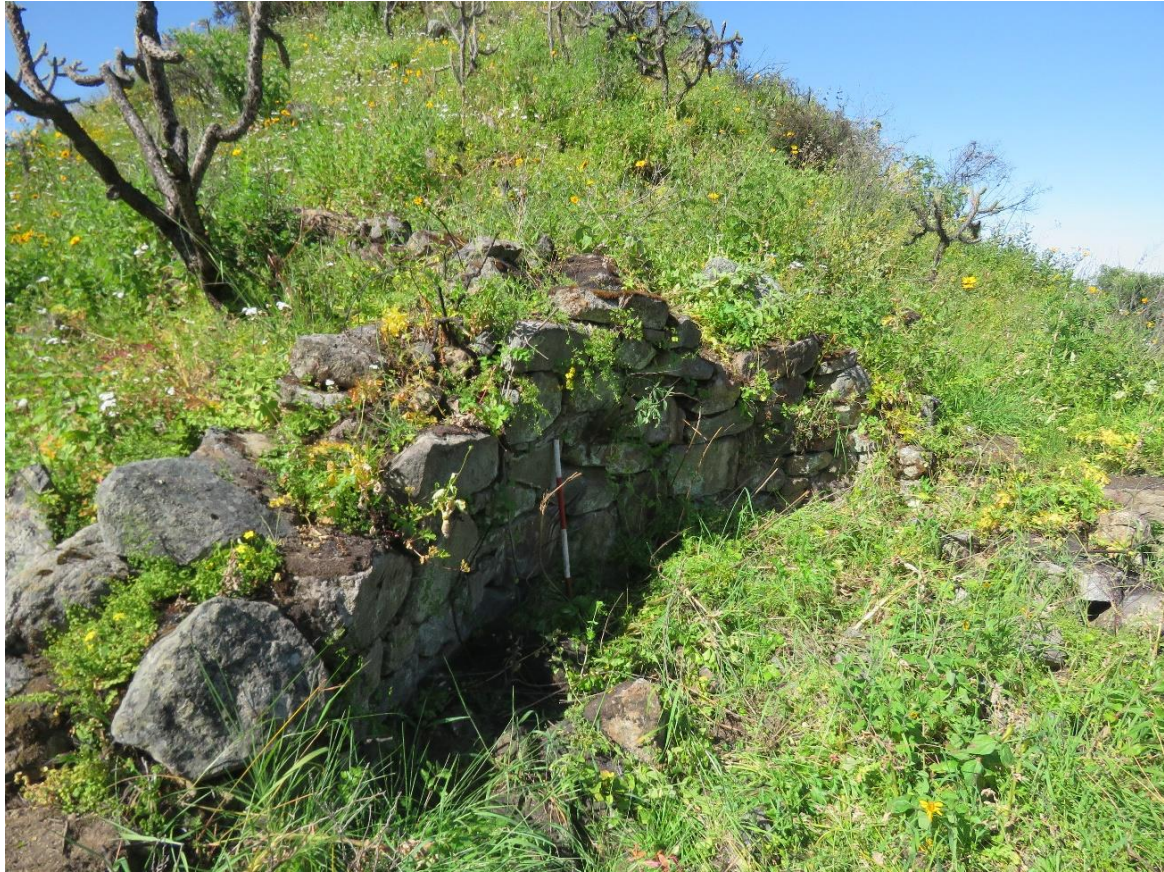
Figura 66: Muro de piedra de un recinto.
