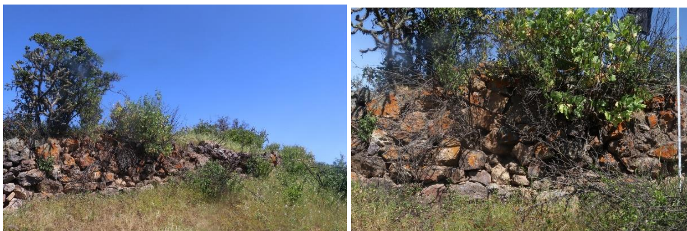
Figura 48 (izquierda): véase la muralla perimétrica. Figura 49 (derecha): detalle de la muralla perimétrica.
