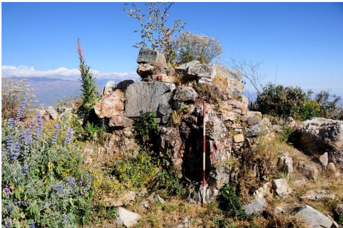
Figura 53: muro del recinto que se encuentra en la colina de estribación corta del lado Sur
