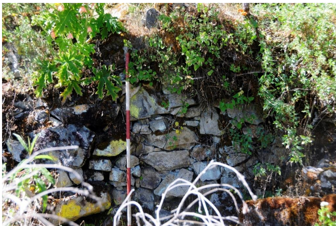
Figura 50: muro de contención que rodea a la colina de estribación corta central, formando una plataforma.
