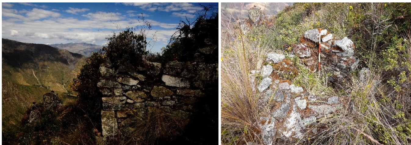
Figuras 20 y 21: muro externo de una estructura rectangular (izquierda) y una posible chullpa (derecha), sector A.
