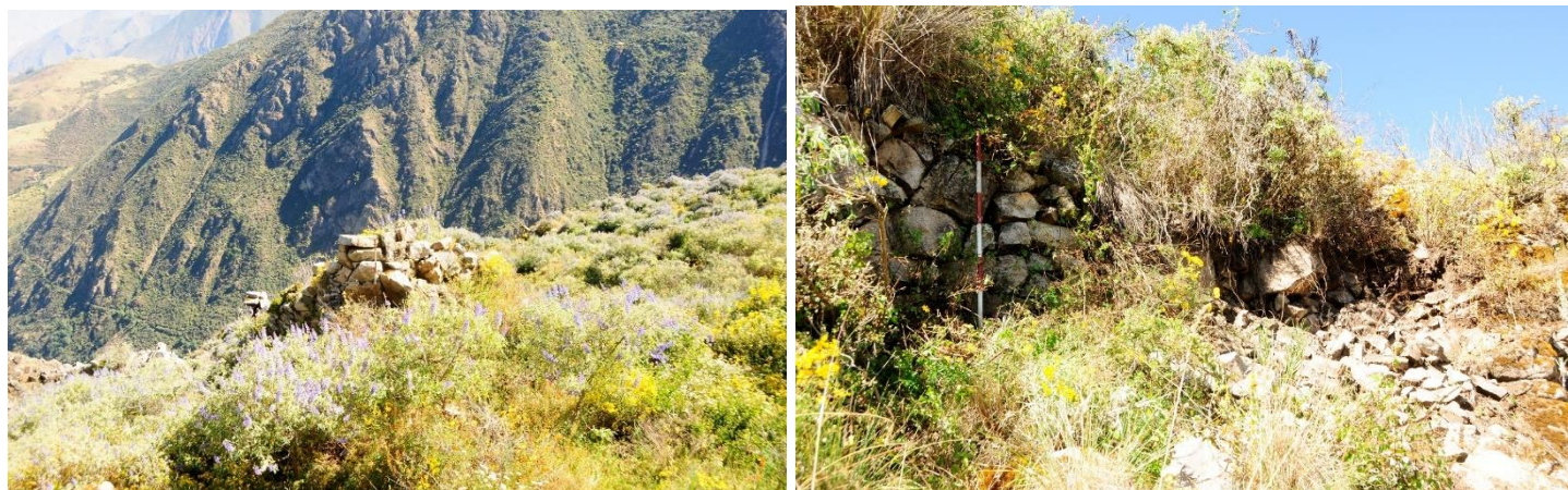
Figura 97 (izquierda): Muros independientes sobre un afloramiento rocoso, lado sur del sector A. Figura 98 (derecha): Muro de contención caído por factores naturales, lado sur, sobre una ladera empinada.
