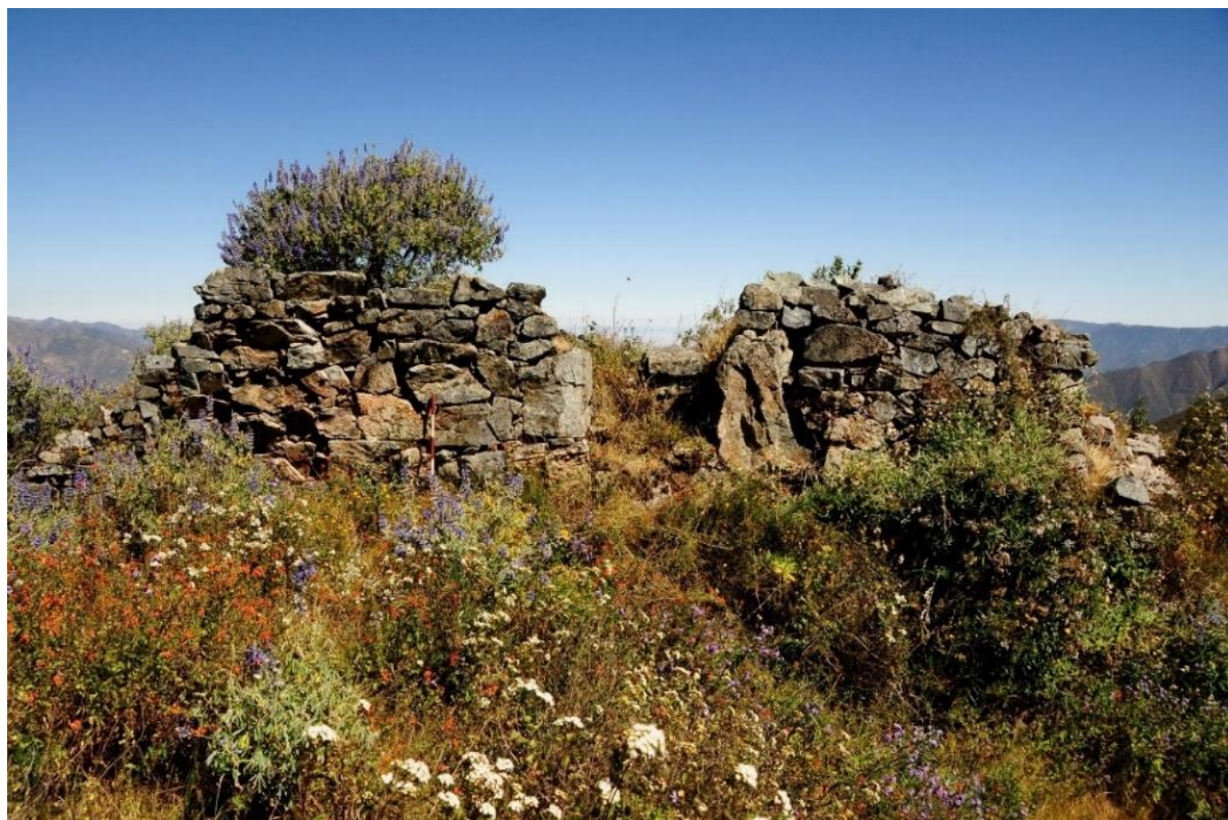
Figura 88: Estructura arquitectónica ubicado en el lado Noreste del sitio, este es del tipo estructura-chullpa. Véase el acceso.
