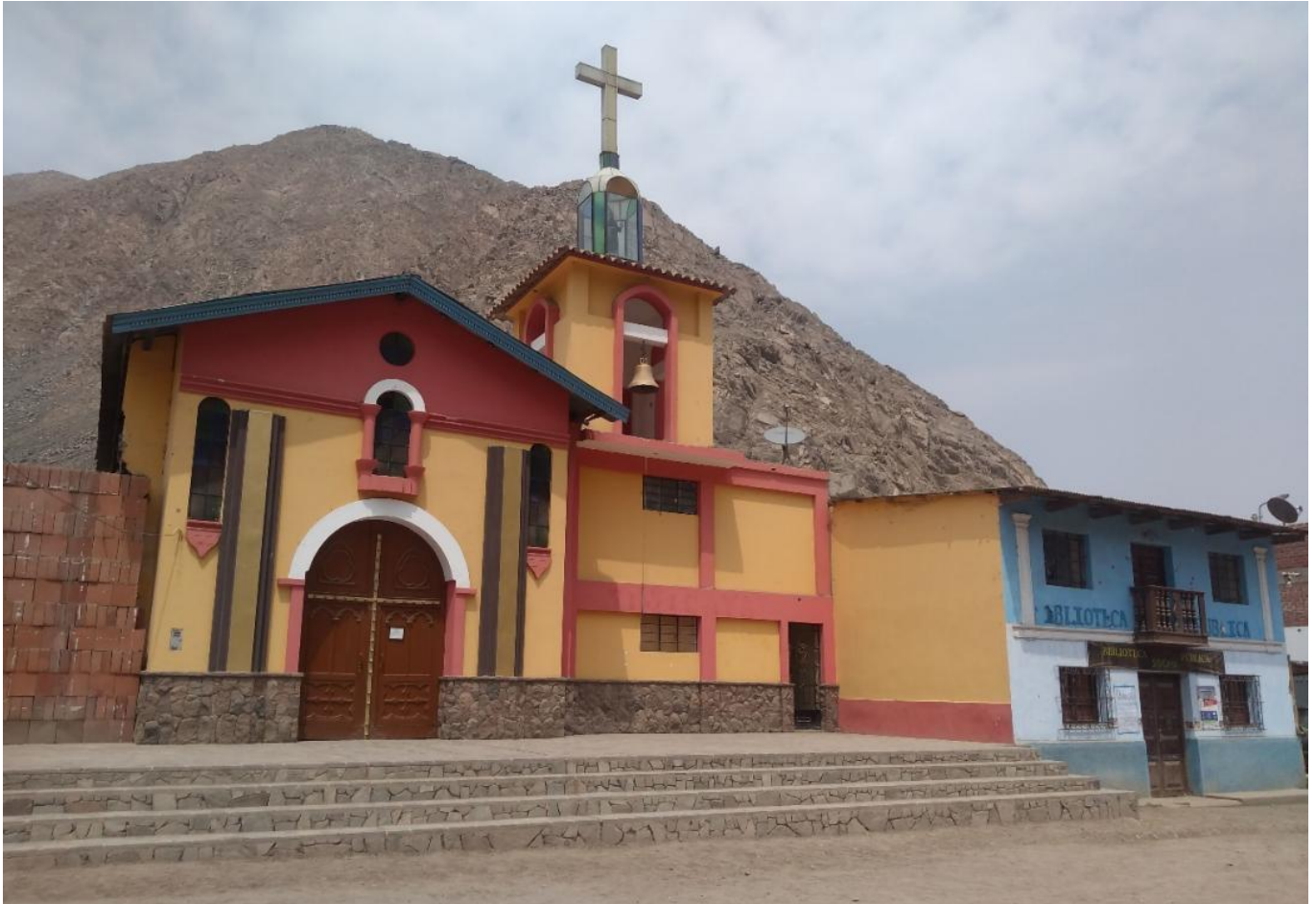
Figura 1: Vista del templo católico de Sisicaya (2020).
