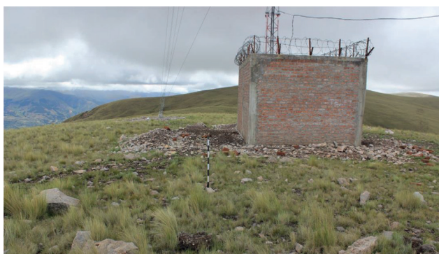
Figura 22. Cimentaciones de viviendas circulares Huarpa, afectadas por la instalación de antenas internet (Claro).
