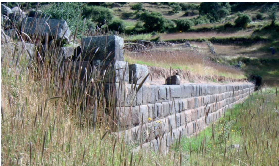
Figura 11. Muro exterior de la Kancha 4.
