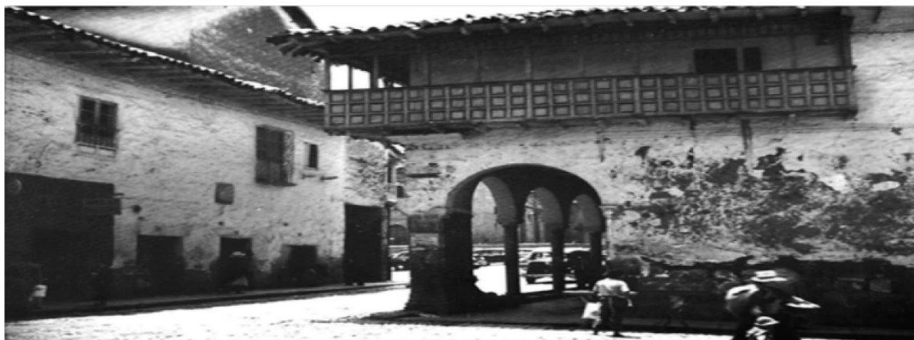
Figura 45 y 46. Imágenes correspondientes a la calle Mantas antes del sismo de 1950, nótese el detalle que en la fachada del frente y que da acceso entre la Av. El Sol y la plaza de Armas no se encuentran las arquerías y que estas fueron como consecuencia de las demoliciones hechas. https://www.taringa.net/+imagenes/fotografias-del-cusco-antiguo-parte-II_12pt8n .
