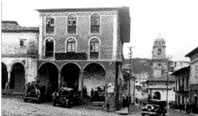
Figura 47. En esta imagen se puede apreciar el nuevo edificio hacia Portal Espinar de tres niveles https://www.taringa.net/+imagenes/fotografias-del-cusco-antiguo-parte-II_12pt8n
