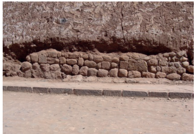
Figuras 8 y 9. Fotografías de evidencia arqueológica en el frontis y en el interior del inmueble N° 004. Se observa elementos líticos reutilizados en estos muros, construidos donde primigeniamente se ubicaban las plataformas prehispánicas que sostenían el desnivel y la canalización del río Saphy antes Watanay.
