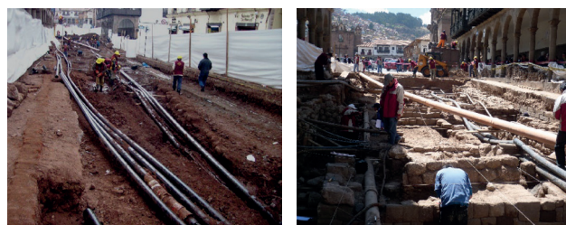
Figuras 82 y 83. Vista de tuberías luego de las excavaciones restringidas, atraviesan todos los hallazgos de la calle Mantas.
