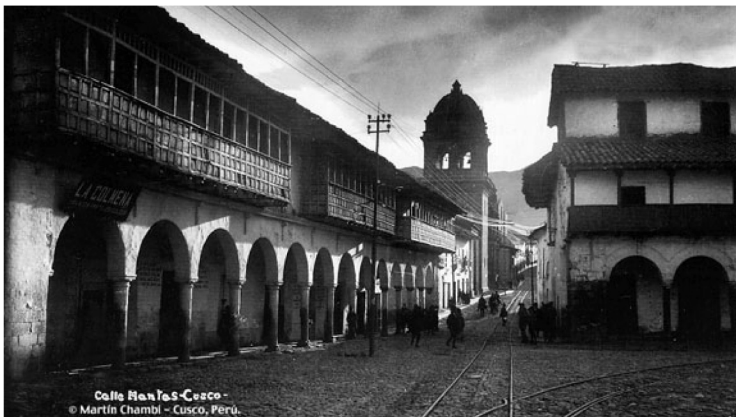
Figura 48 y 49. Panorámicas opuestas de calle Mantas correspondiente a la primera década del siglo XX https://www.taringa.net/+imagenes/fotografias-del-cusco-antiguo-parte-II_12pt8n .
