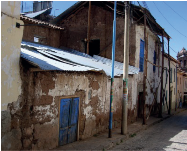
Figura 16. Frontis del inmueble en la calle Suecia e interior del predio.
