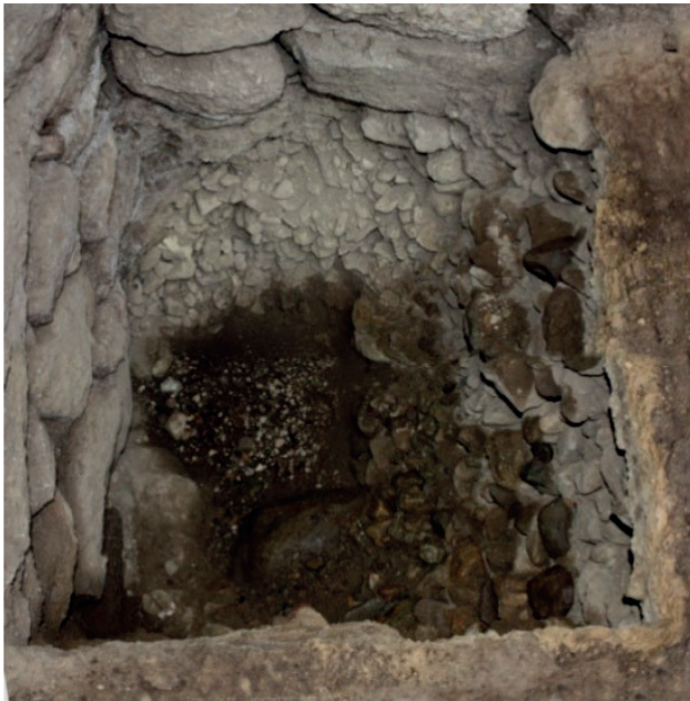
Figura 23. Recinto 09, vista del relleno del tratamiento de piso, con fines de filtrar la humedad.
