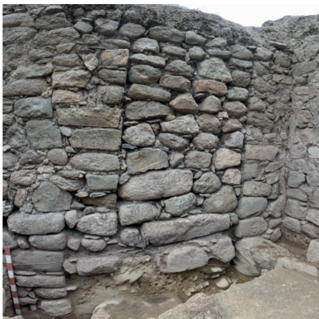
Figura 38. Tres etapas constructivas. (1) La jamba original Inka, (2) el vano de acceso, (3) el tapiado del vano.
