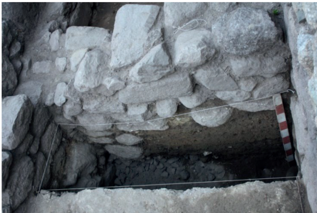
Figura 24. Recinto 10, vista de la cimentación irregular.
