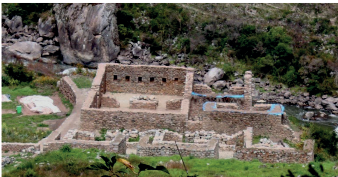
Figura 3. Vista general del sector A.
