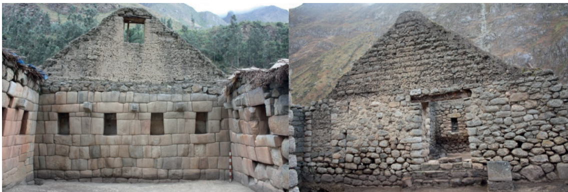
Figura 36. Colocación de nuevos elementos estructurales como los hastiales de adobe.
