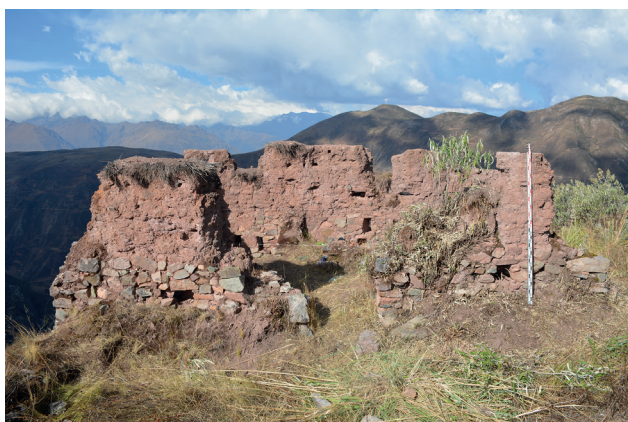
Figura 5. Vista del paño externo de la qollqa de Wata.
