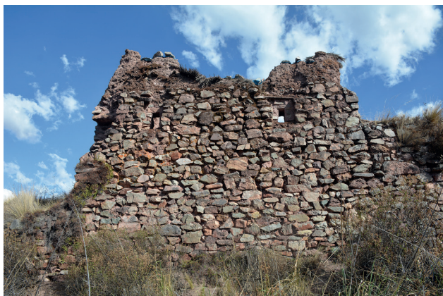
Figura 7. Fotografía del paño exterior del muro este de la qollqa.
