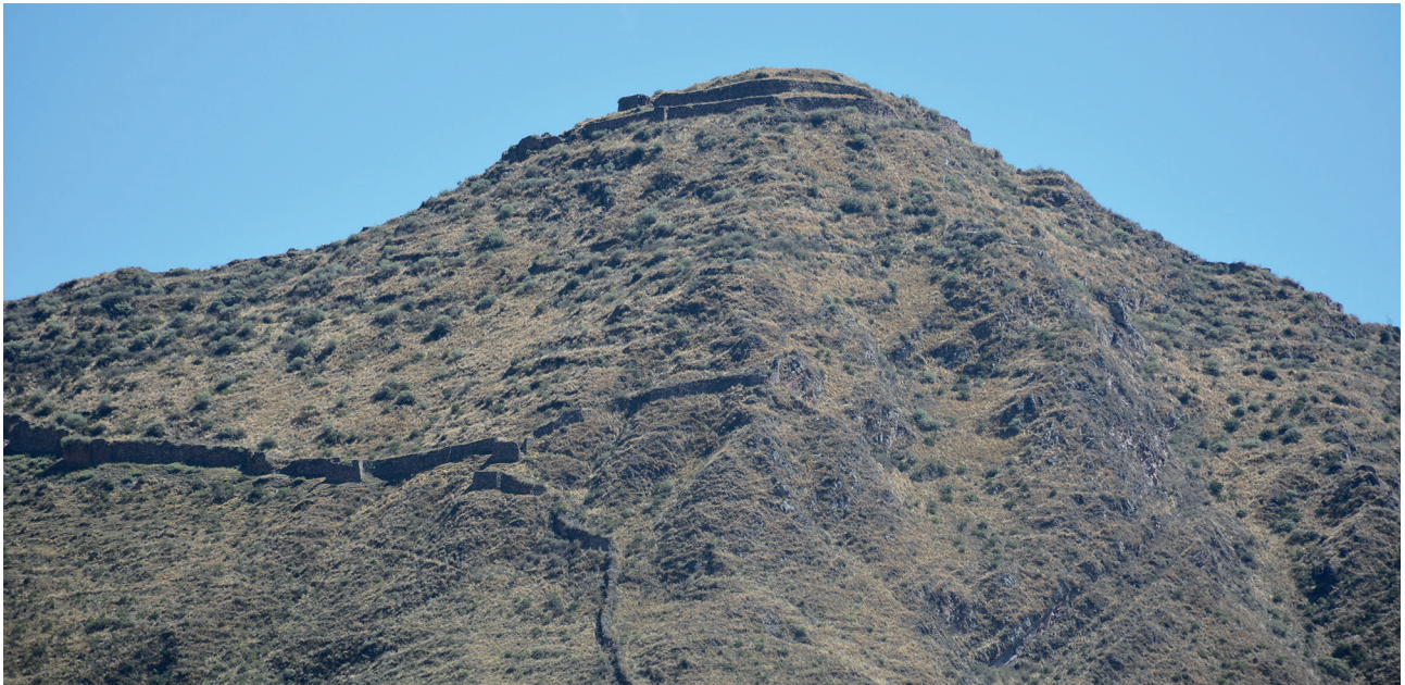
Figura 2. Vista general de Wata y la muralla que la delimita.
