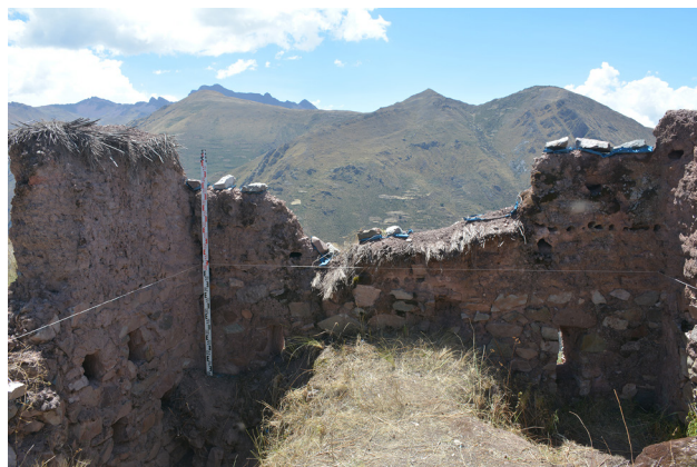
Figura 8. Fotografía del paño interior del muro este de la qollqa.
