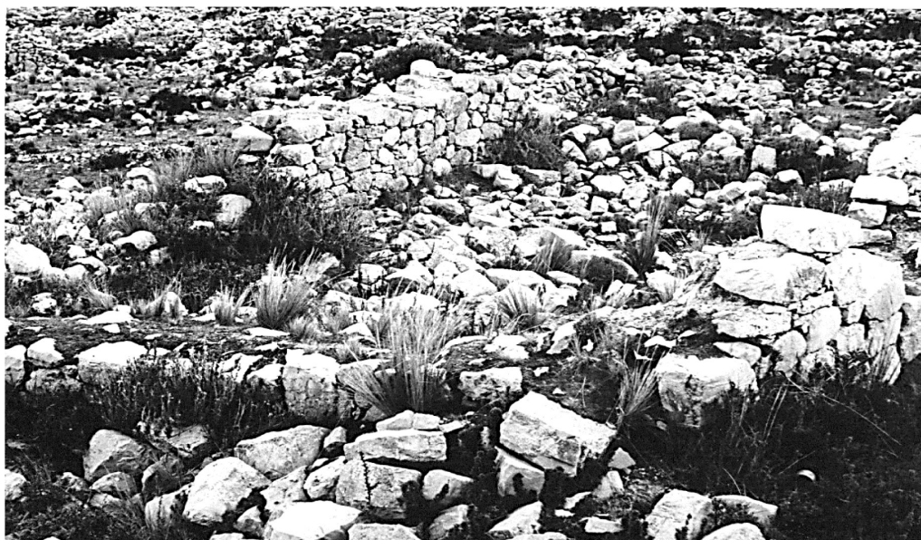
Figura 3. Las piedras naturales de sectores Guanka I con aristas provenientes de canteras geológicas, se utilizaron para asentarlas por morfología irregular en muros de dos hileras paramentales conformantes de plantas ovoidales.
