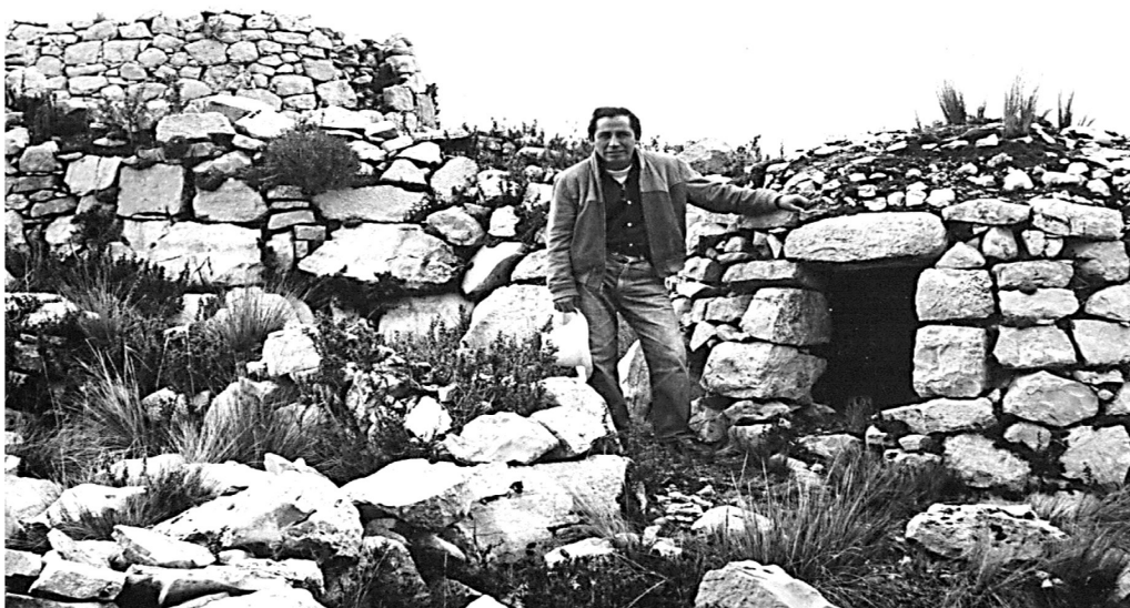
Figura 7. Edificación Guanka II-III (1200 d.C.) cuyo vano está conformado por piedras preparadas y selectas canteadas para configurarlo; apreciar la cubierta combada mostrando piedras pequeñas entre capas de barro, las que son sostenidas por lajas rocosas alargadas tramadas interiores entremezcladas con barro. Esta cubierta combada representa el modelo que habrían tenido todas las unidades arquitectónicas del asentamiento arqueológico.
