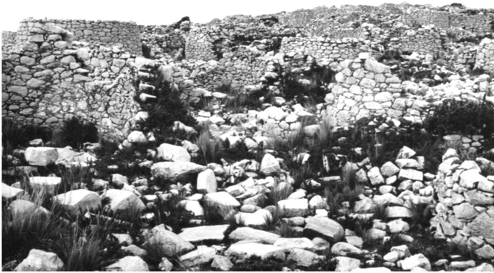
Figura 10. Edificaciones circulares aglutinadas Guanka III (1300 d.C.) las que exponen desplomes parciales de algunos de sus muros.
