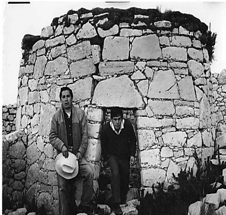
Figura 16. Edificio Tunanmarka Guanka III-IV, fase en que las piedras de construcción son labradas y pulidas las que se asientan en aparejo semi-alineado para obtener morfología de mayor consistencia y acabados de mejor resolución. En la foto Simeón Orellana Valeriano con sombrero en la mano.
