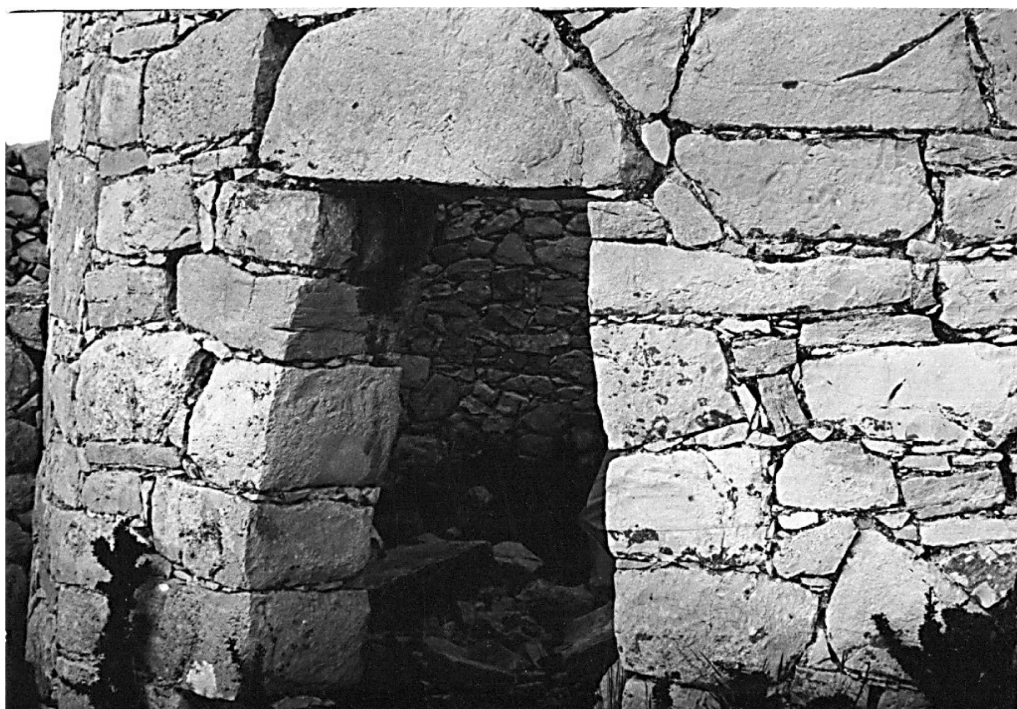
Figura 17. Primer plano de la portada perfilada con bloques labrados, esquinas rectas, el vano trapecial ligeramente abombado en el tercio medio y dintel monolítico en morfología triangular Guanka III-IV.
