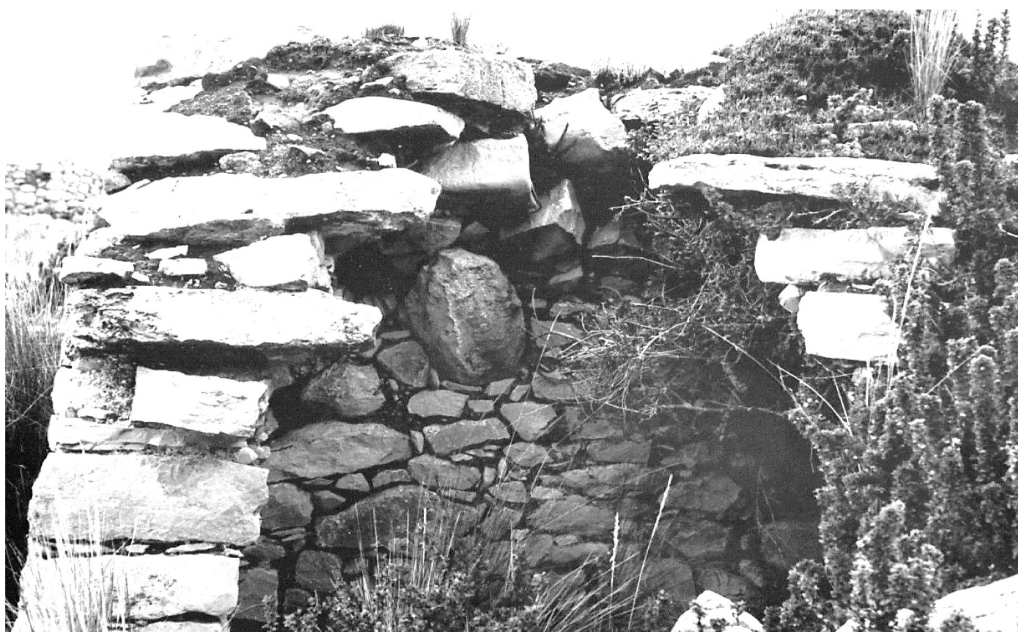
Figura 8. Ilustración de cómo están conformados los litos alargados que sostienen el entramado del techo de las unidades arquitectónicas de Tunanmarka en sus diferentes fases.
