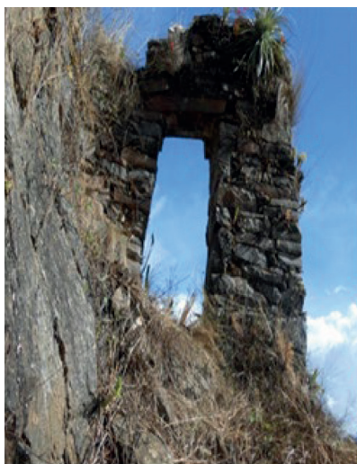
Figuras 20 y 21. Estado de conservación crítica de la Portada, muros pandeados.
