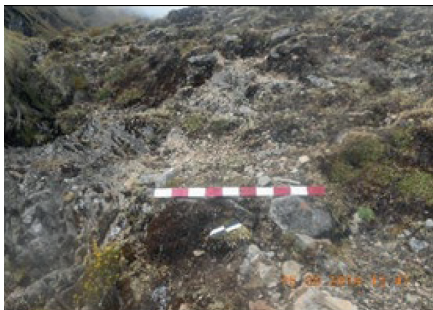
Figura 33. Evidencias de escalinatas, que están bastante deterioradas.
