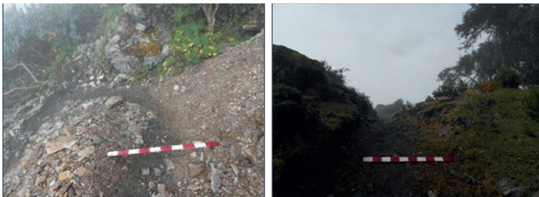
Figuras 41 y 42. El camino con desgaste por uso continuo, y deterioro por factores climáticos y antrópicos.
