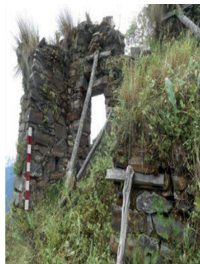
Figuras 20 y 21. Estado de conservación crítica de la Portada, muros pandeados.
