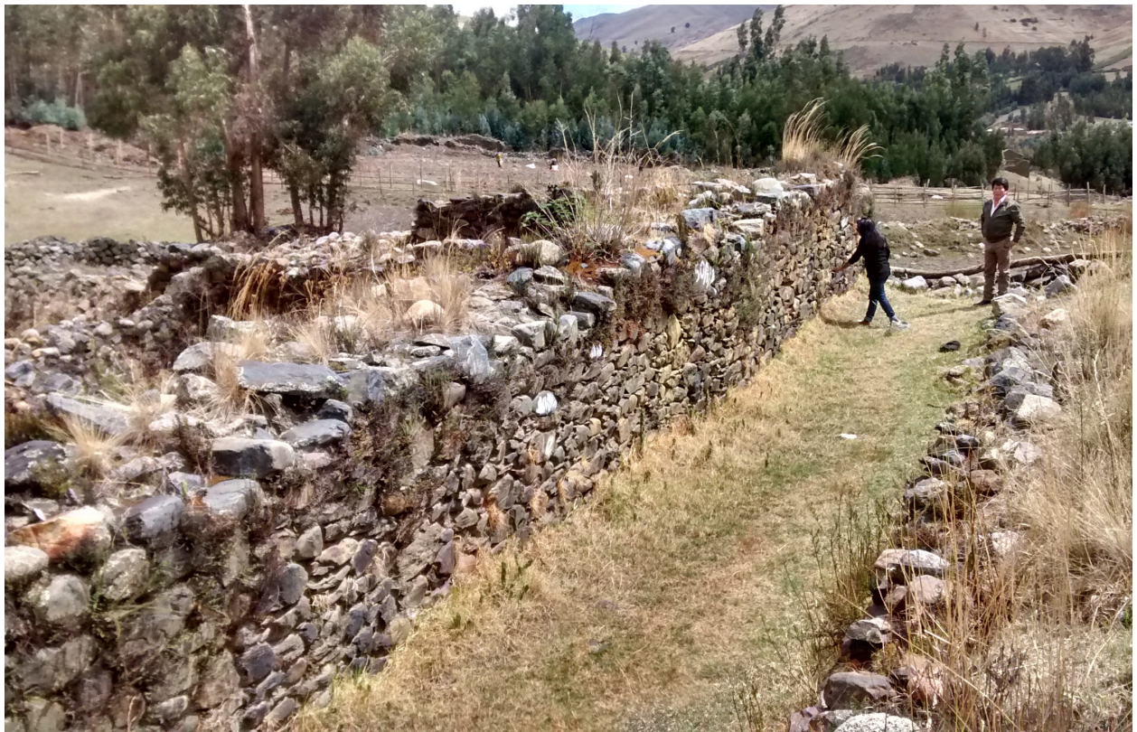
ArqPerCOARPE | Figura 14. Pasillo ubicado en el flanco norte de la estructura tipo kancha, en medio del ushnu y la kancha. Nótese la presencia de aleros en la parte superior de los muros y el acabado con la técnica de la pachilla (Fotografía: Miguel Aguilar).
