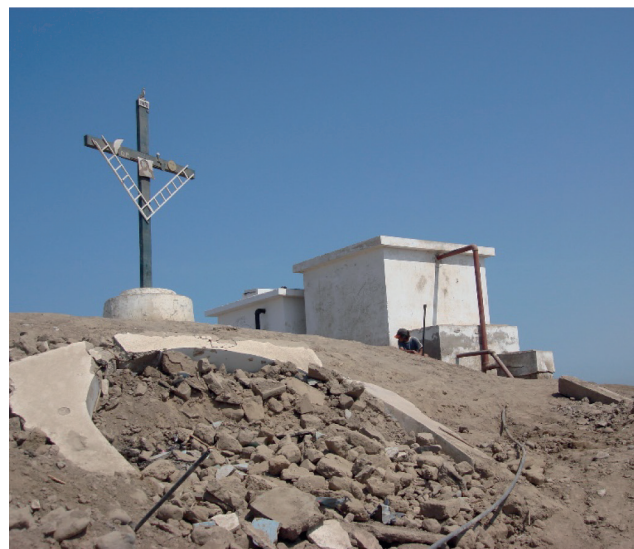
Figura 30. Vista de la parte más alta de la Huaca Santa Rosa donde se ubica el reservorio moderno y la cruz.
