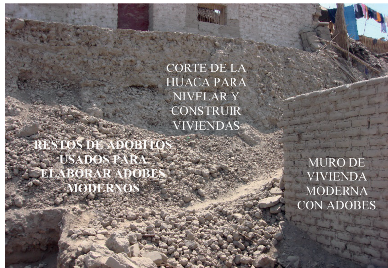
Figura 23. Vista del corte realizado por los moradores hacia el lado sur de la Huaca Santa Rosa y uso de los rellenos (Adobitos) para elaborar adobes modernos.
