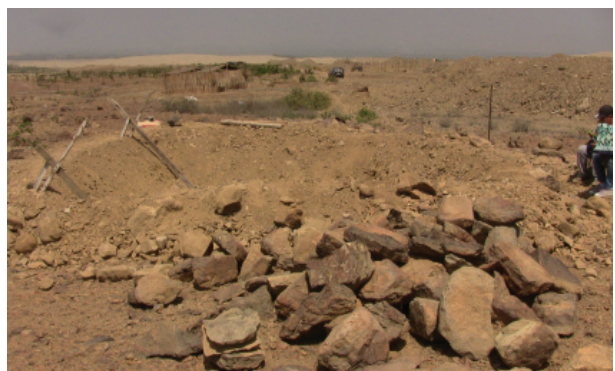
Figura 62. Inicio de construcción de reservorio. Foto Víctor Corcuera 2014.
