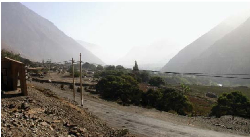
Figura 4. Carretera Lima-Canta inmediatamente al pie del sitio arqueológico con quilcas de Pucará. Esta carretera es el principal agente de afectación del sitio. Foto Gori Tumi 2008.
